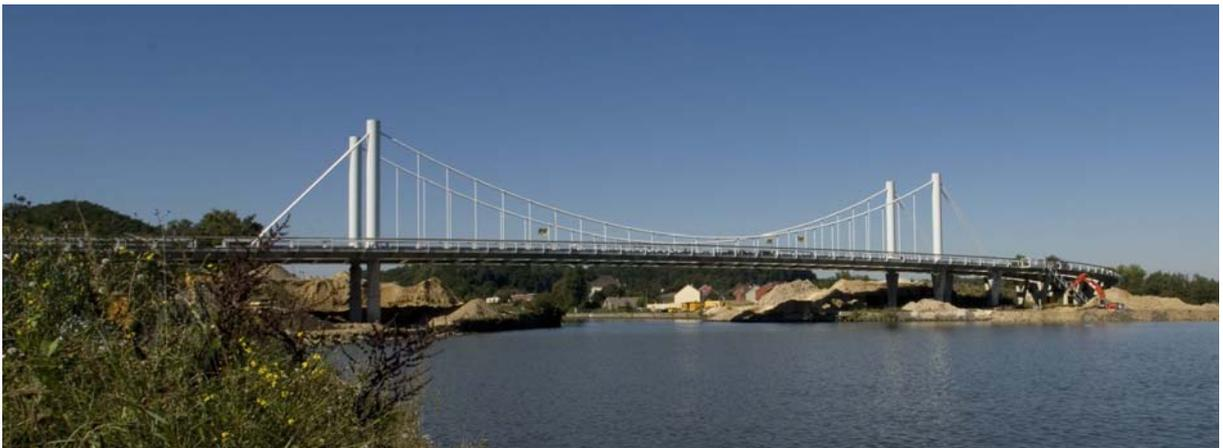
Spécialement développé par Freyssinet pour répondre aux contraintes des câbles porteurs des ponts suspendus, le toron Cohestrand est mis en œuvre pour la première fois à l'échelle industrielle sur le pont de Kanne, en Belgique.
