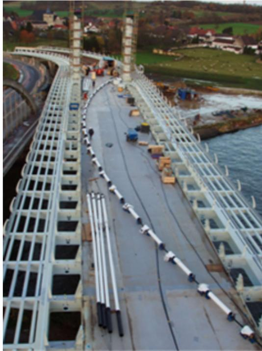
Fig. 2 - Préfabrication du câble sur le tablier / Prefabrication of cable on deck
