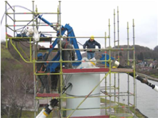
Fig. 5 - Levage par toron de la seconde extrémité du câble / Strand lifting of second end of cable
