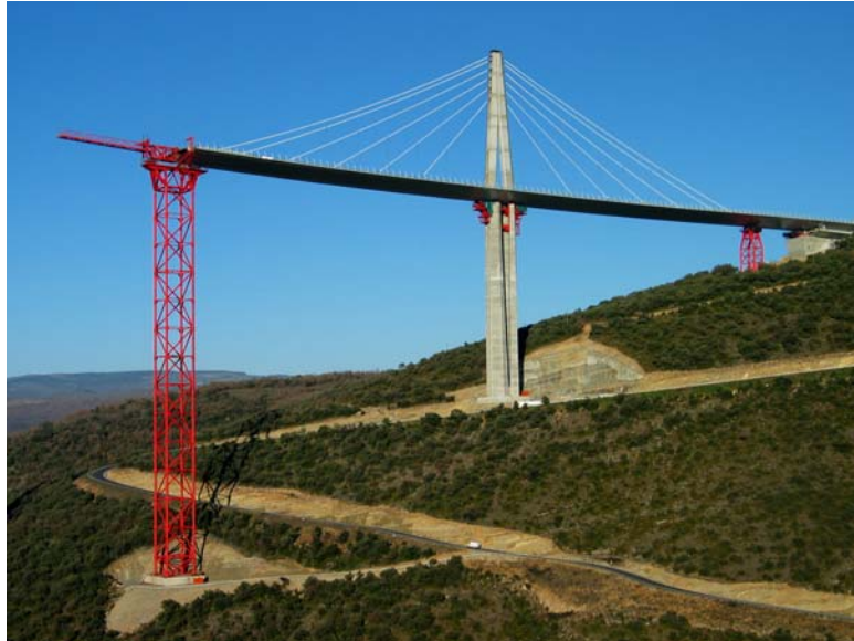
Photo. 1a. Le viaduc / The viaduct
