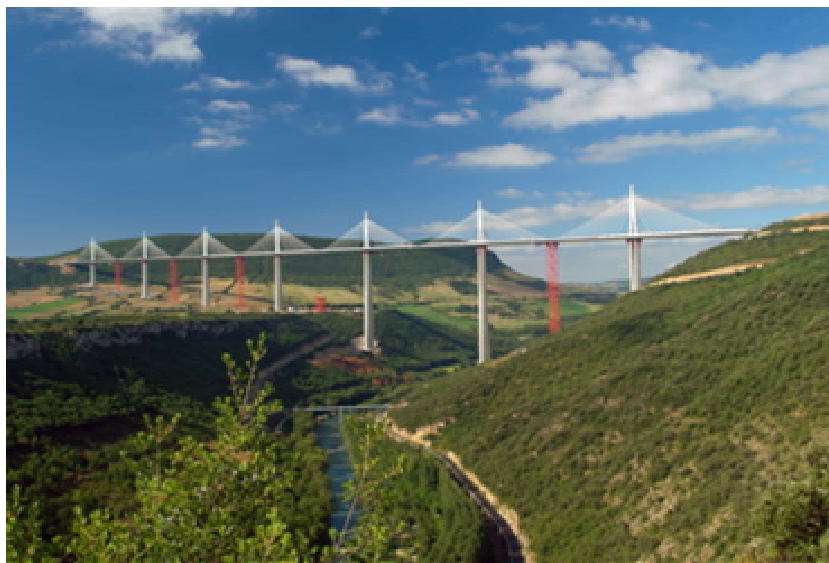
Photo 1. Le viaduc / The viaduct
