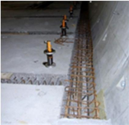
Cette dalle est posée à l'avancement juste derrière le tunnelier afin de permettre la circulation dans le tunnel.
