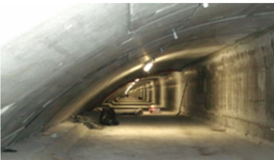
Comme la dalle médiane et la dalle basse, les structures supérieures sont ancrées aux UV aux deux extrémités des tunnels. En revanche, contrairement à la dalle médiane, aucun clavage provisoire n'est laissé dans les structures supérieures. L'ensemble doit donc être capable de reprendre au niveau des ancrages dans le revêtement les efforts engendrés par les déformations gênés (variations thermiques et retrait).
