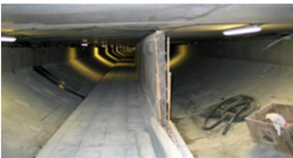
Le radier est réalisé en béton B32. Il comprend 4 caniveaux qui permettent le cheminement le long du tunnel de l'ensemble des câbles d'alimentation électrique des équipements.
