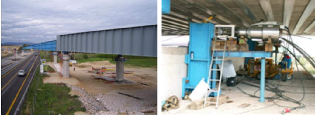
Photos 16a et 16b : VIA 9.41- Tablier en cours de lançage - dispositif de poussage sur culée (vérin 12T15s)
