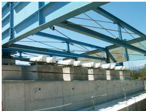
Photo 13 : VIA 9.41 - Accostage Avant bec sur culée C10 – Vue générale des amortisseurs
