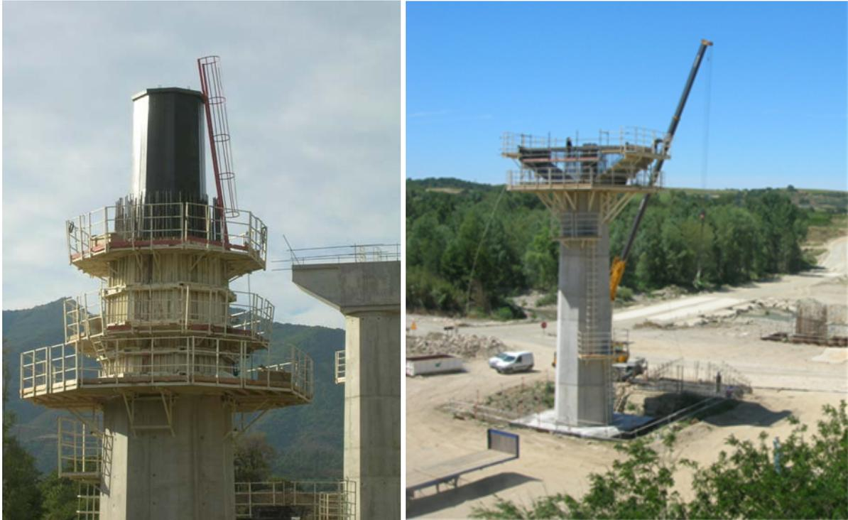
*Photos 7a et 7b : VIA 15.65 – Coffrages des piles (fûts et chevêtres)*
