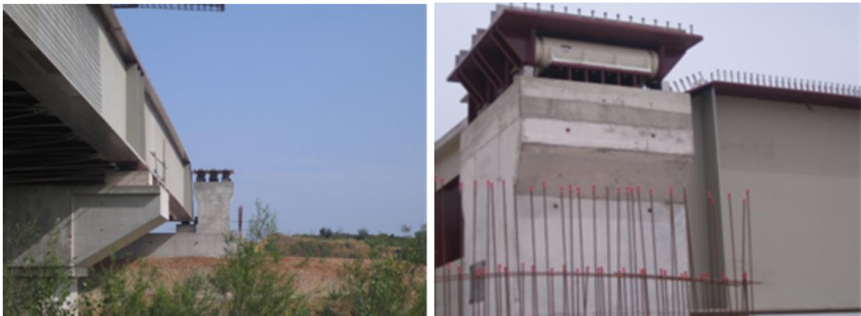
*Photos 8a et 8b : VIA 8.47 – Fin de lancement – Vue des amortisseurs sur les massifs de la culée*
