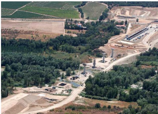
Photo 11 : VIA 15.65 – Charpente en cours d'assemblage sur plateforme
