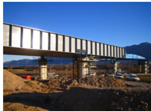
*Photos 15a et 15b : VIA 14.35 - Tablier en cours de lançage*
