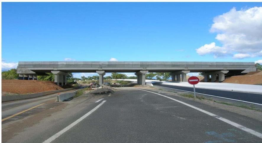
*Photo 1 - PRA 0.94 – Pont à poutres préfabriquées*
