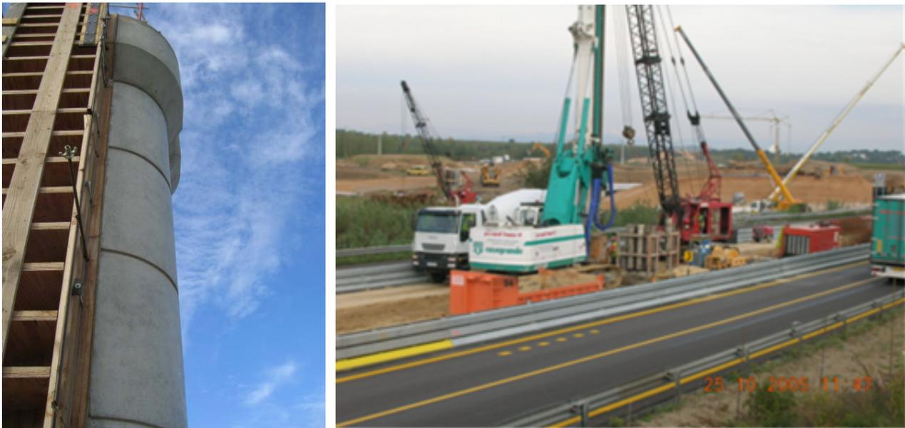
*Photos 14a et 14b : VIA 9.41 – Piles en TPC – Réalisation des pieux forés*
