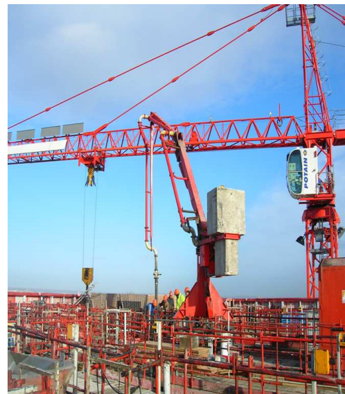
Phase bétonnage avec Mât M3.15
