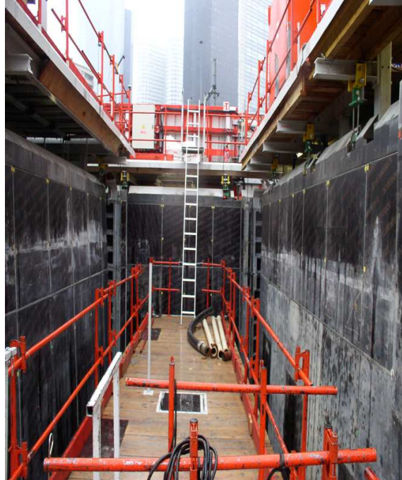
Vue intérieure après hissage des cellules 1ère face coffrante
