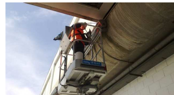
Visite sommaire sur les appareils d'appui du Terminal 2A, Paris-Charles de Gaulle
