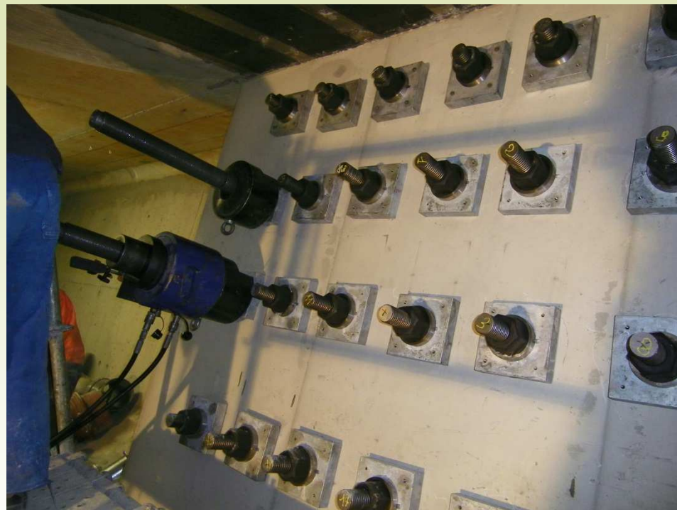
Mise en tension barres de clouage
