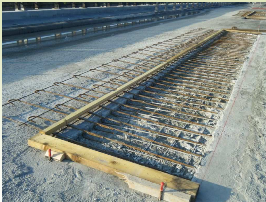
Engravure en zone centrale / hydrodémolition
