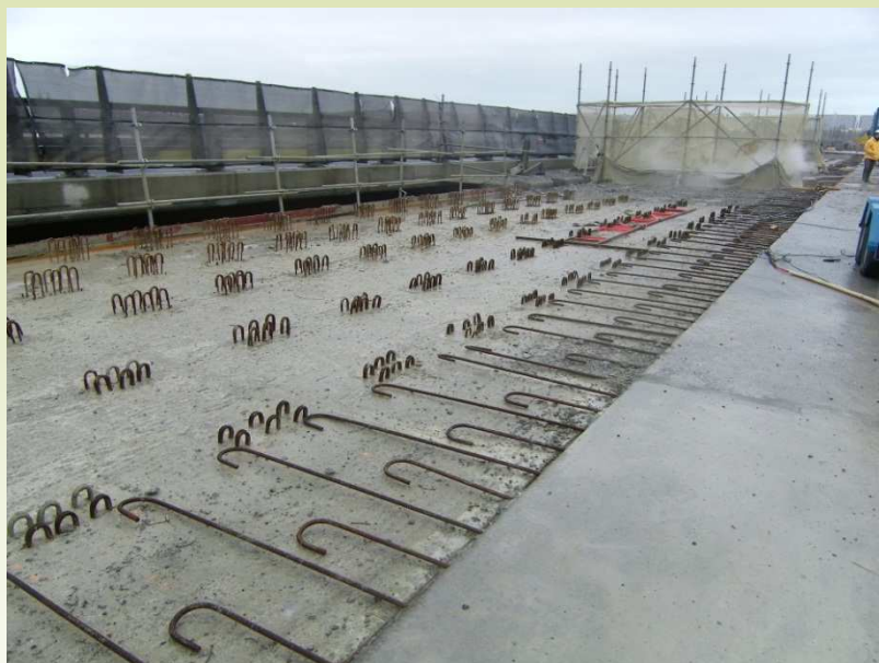
Décapage et réalisation de niches à l'hydrodémolition
