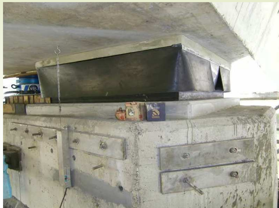
Renforts de « coin » des têtes de piles
