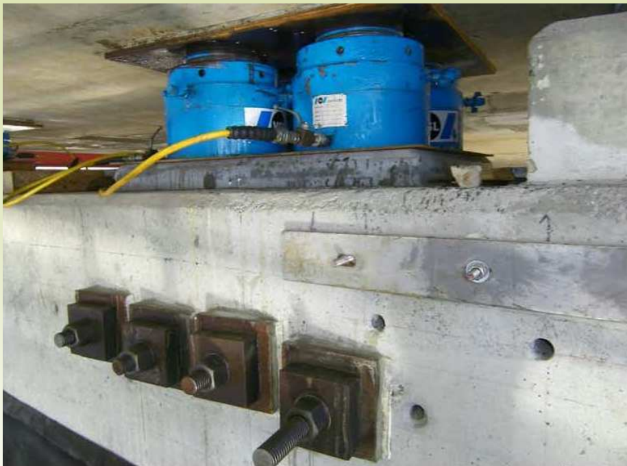
Verinage de puissance 1 500 tonnes
