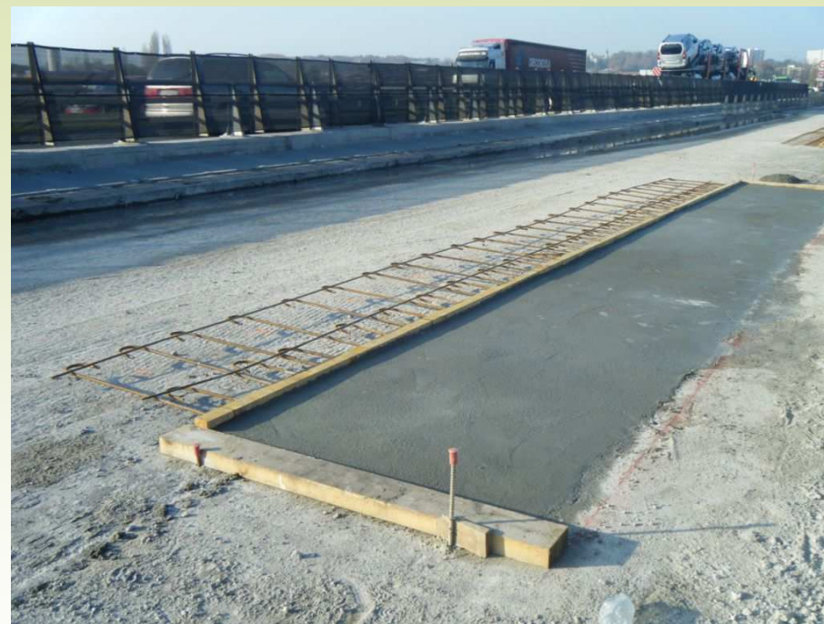
Ferrailage de recouvrement et bétonnage
