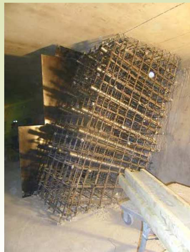
Ferraillage et coffrage des renforts
