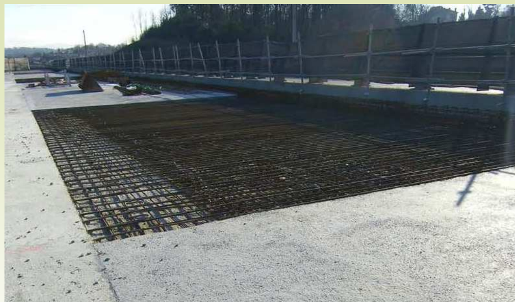
Ferrailage courant de zone latérale
