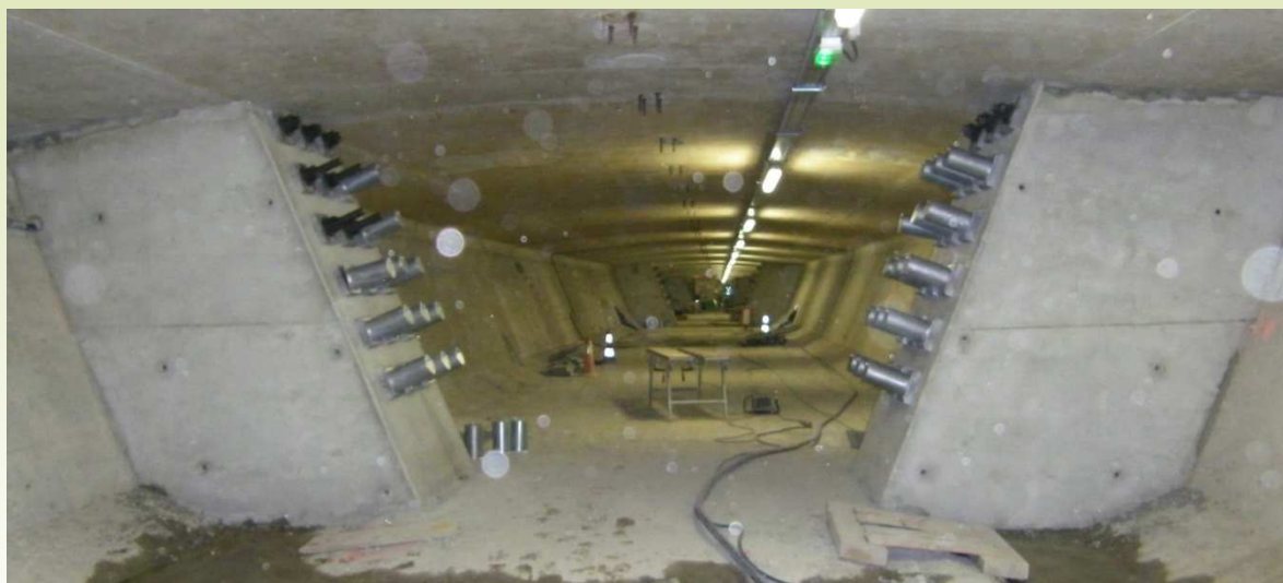
Vue des renforts terminés
