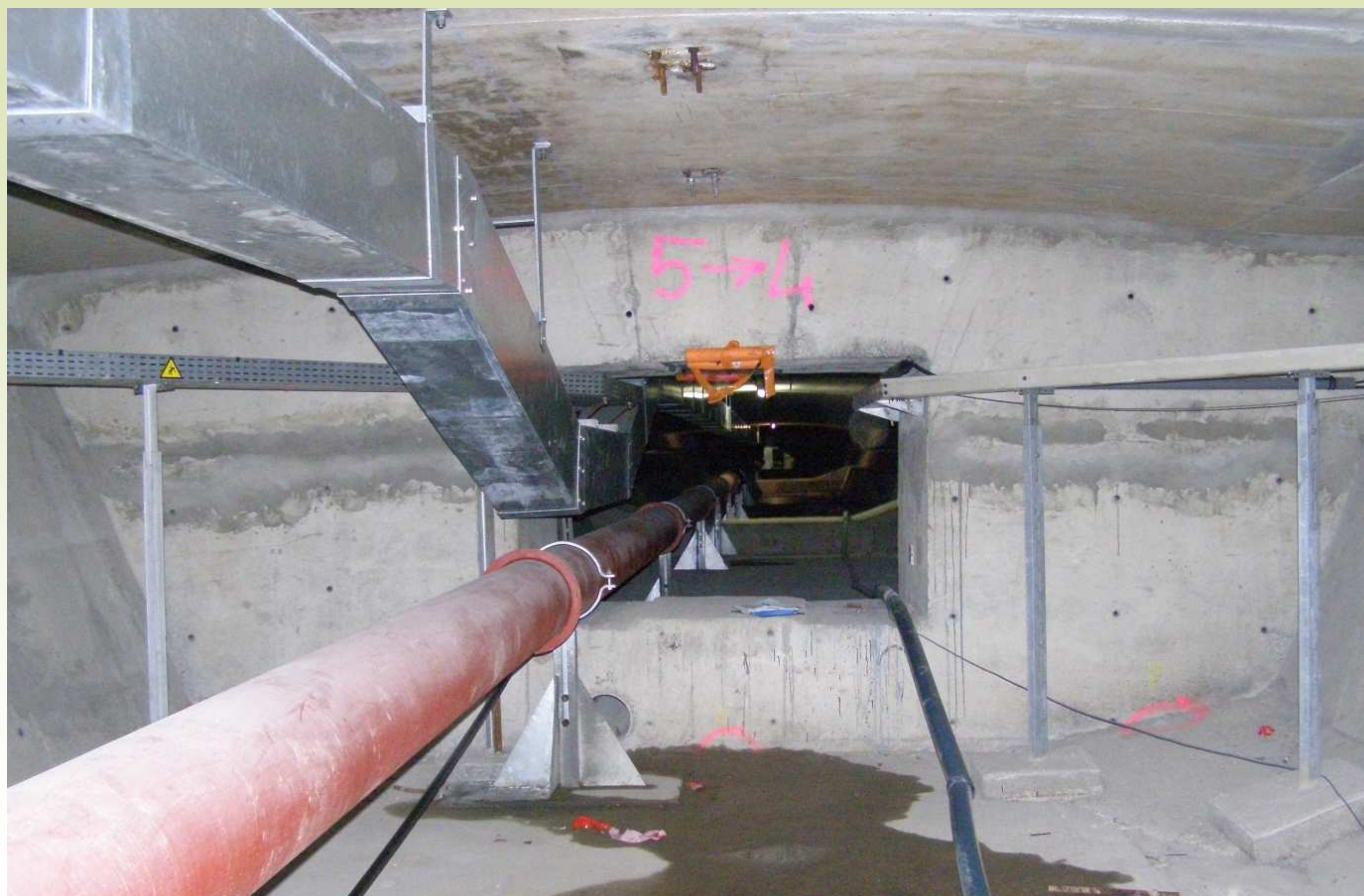
Diaphragmes appuis P4 à P8 – Etat de l'existant
