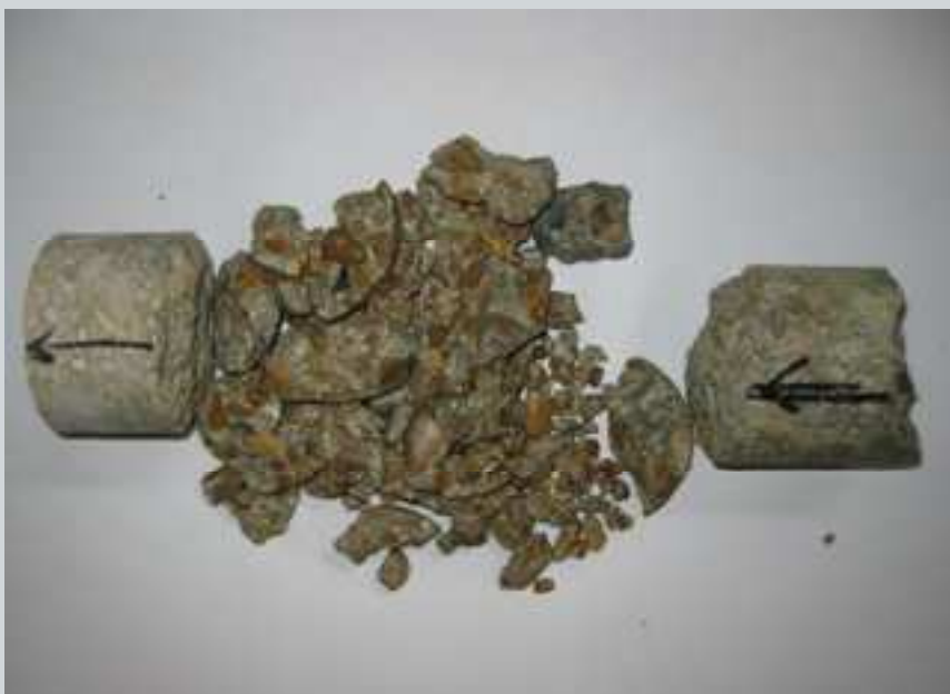
Carottage sur l'entretoise TPC – Pile P3
