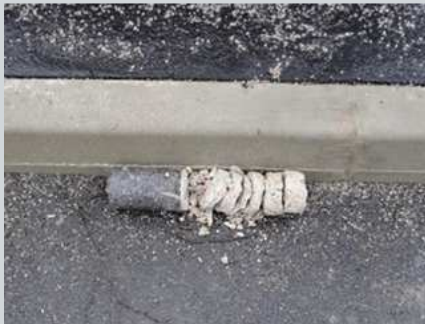
Carottage hourdis en rive de dalle entre C1 et P2
