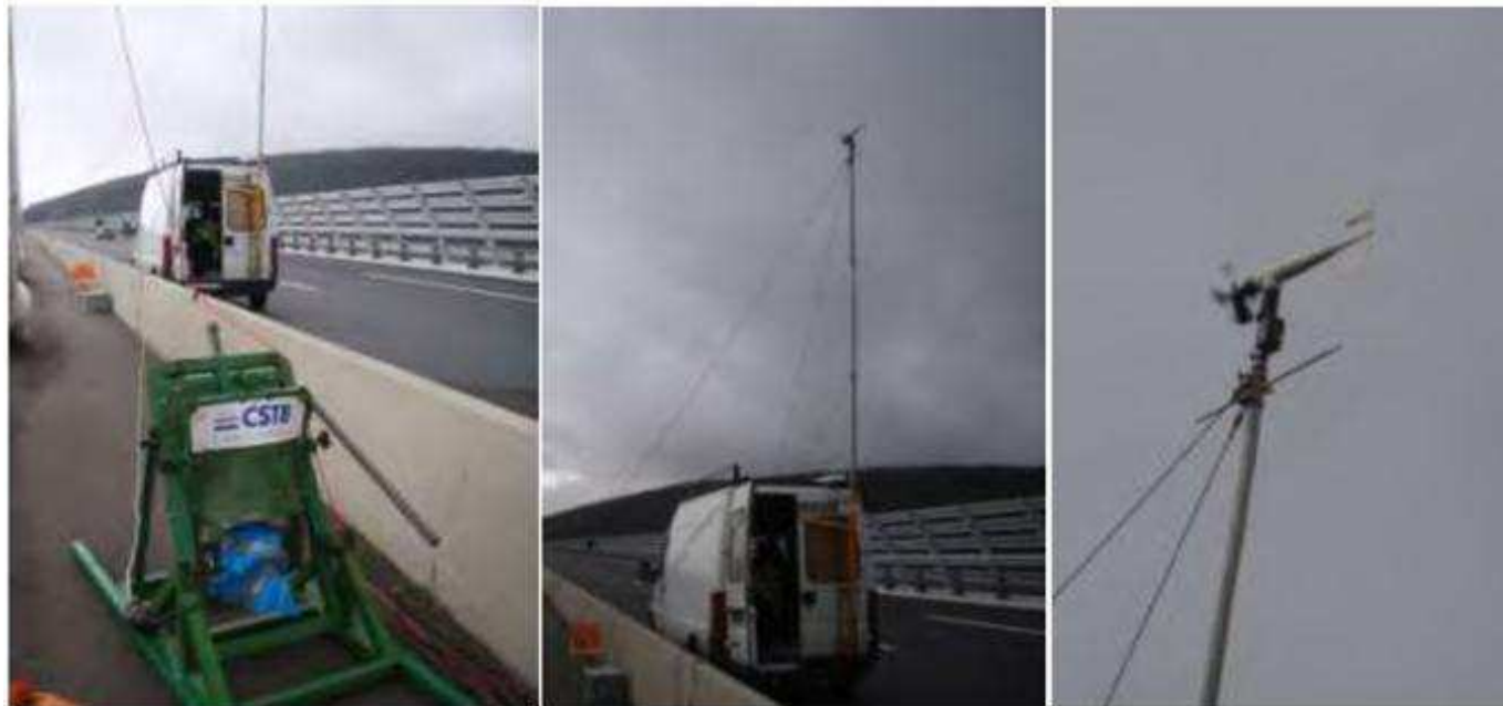
Mât anémométrique pour la mesure de la vitesse de vent en cours d'essais
