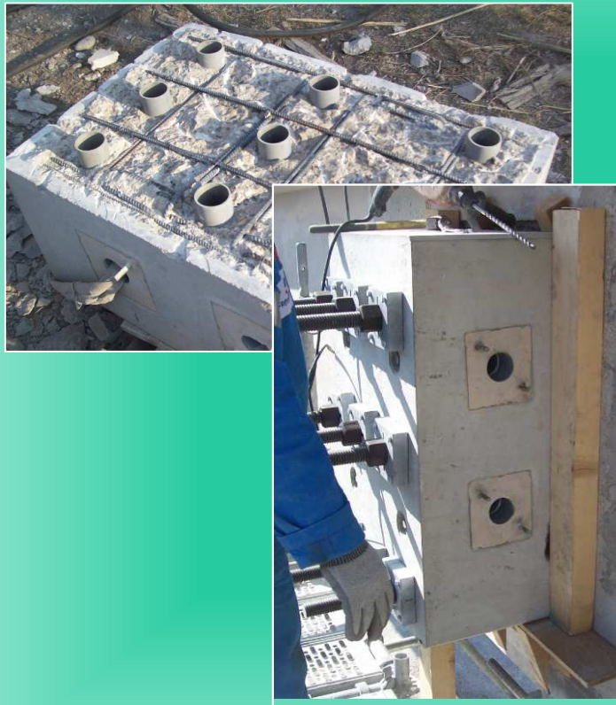
Préparation pour la mise en œuvre du blochet
