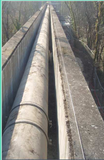
Vue du pipeline après dépose de dalles Présence d'une ligne de vie
