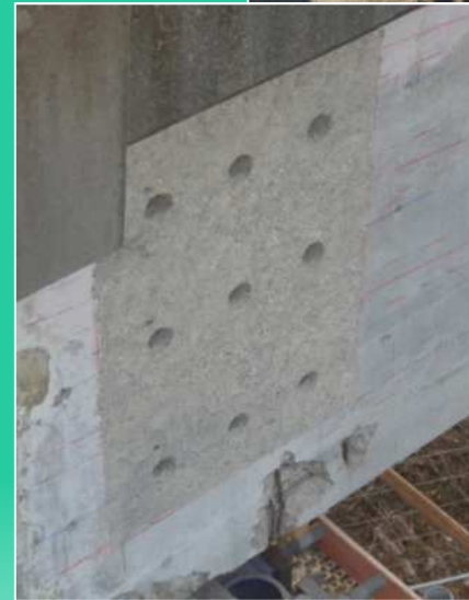
Carottages pour implanter les blochets de la précontrainte additionnelle
