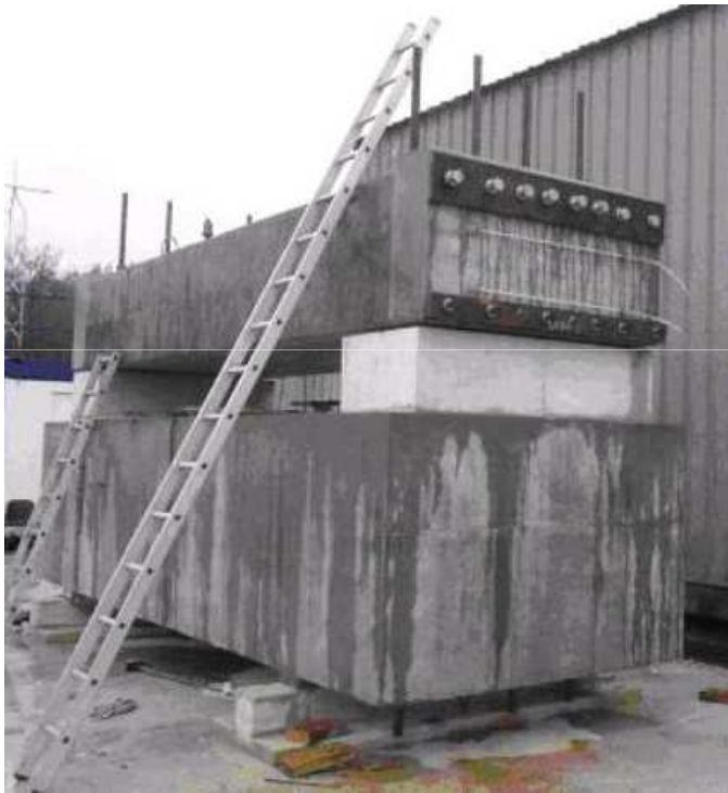
Photo du montage de l'ensemble {poutre + bâti}
