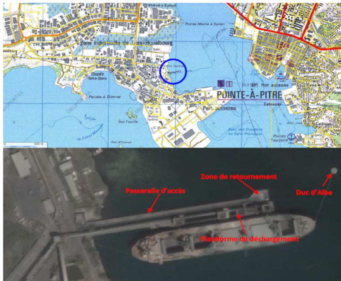
Implantation et vue générale de l'appontement de Jarry
