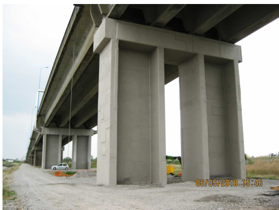
Pile réparée et protégée par un revêtement LHM
