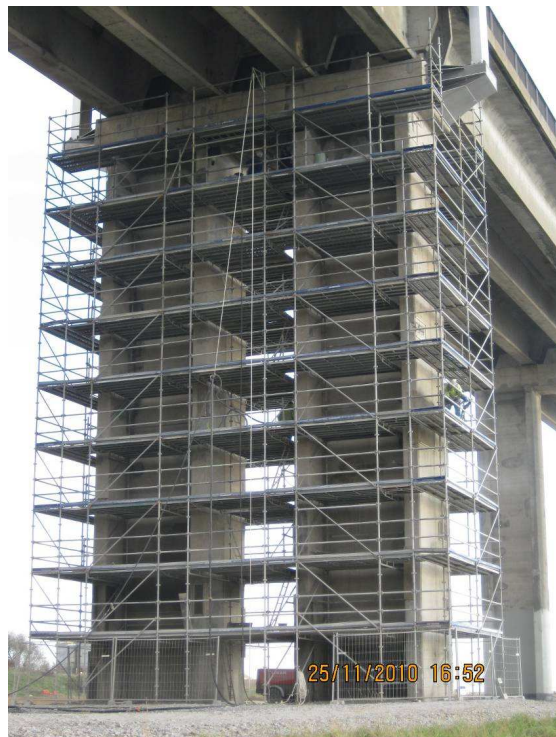
Accès sur pile terrestre
