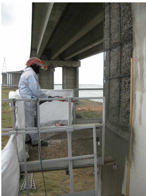
Réparations par béton projeté
