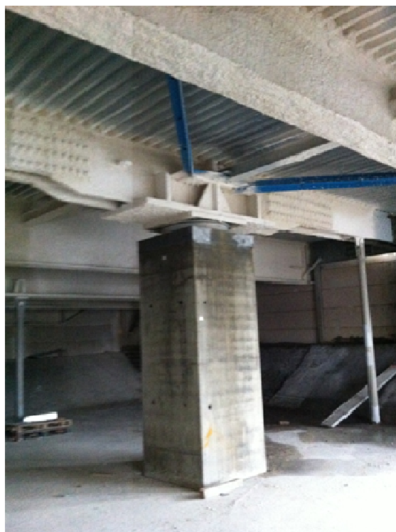
Jonction entre une pile béton et la structure métallique
