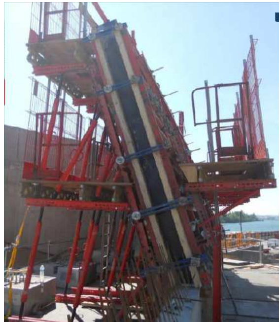
Adaptation des coffrages pour les éléments inclinés
