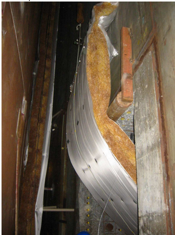
Mise en place isolation
