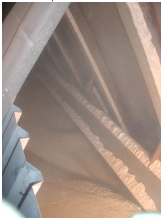
Perlite : mise en place et vibration
