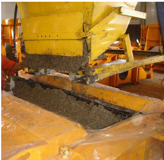
Bétonnage et vibration
