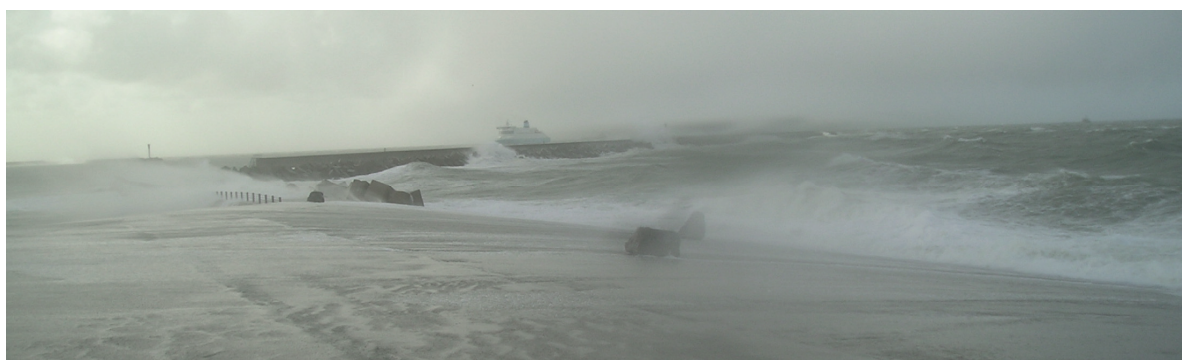
Digue de Ruytingen - Tempête de Mars 2007
