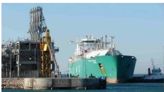
Construction des Réservoirs LNG ENTREPOSE Projets / BYTP
