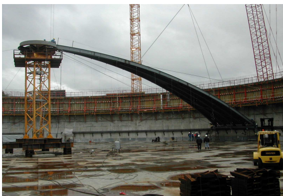
Montage éléments de toit
