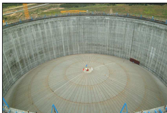
Levage à l'air du toit
