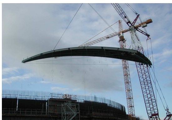
Levage éléments toit (~25t)
