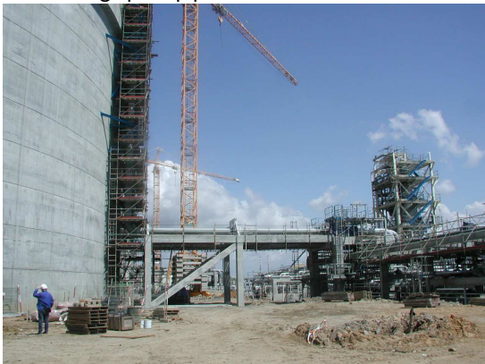
Échafaudage pour pipe rack
