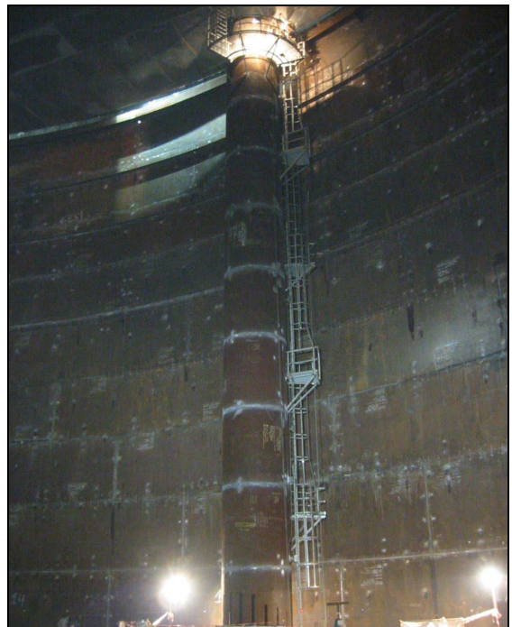
Montage tuyauteries internes
