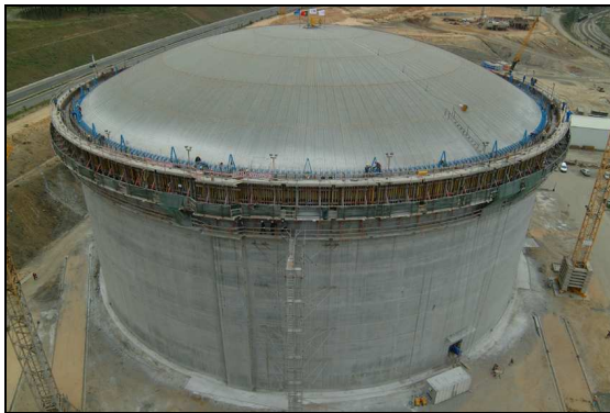
Montage soudage barrière vapeur + installation isolation de fond
