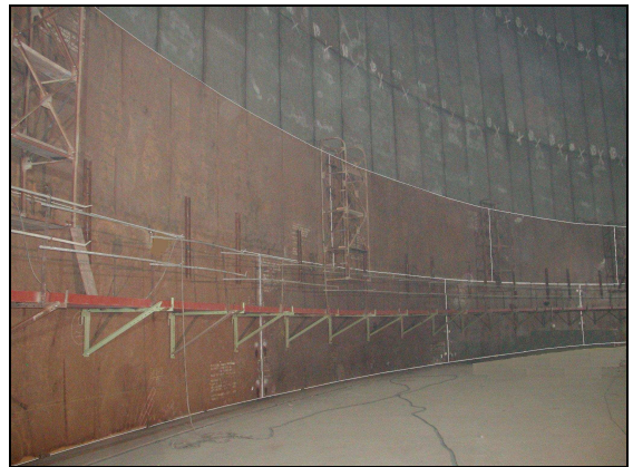
Installation isolation de fond
