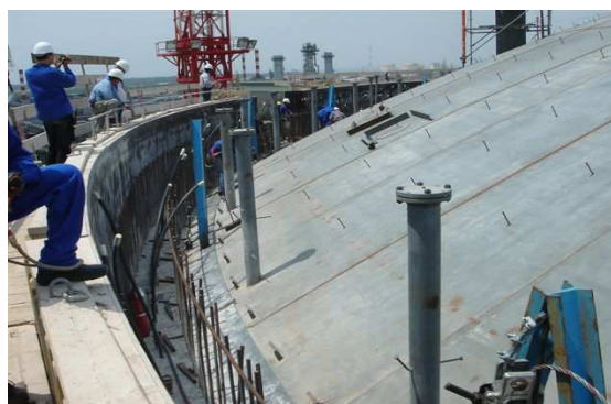
Raccordement toit (position haute)
