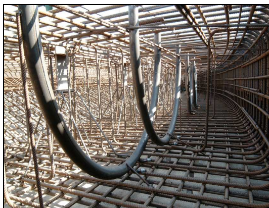
Construction mur béton
