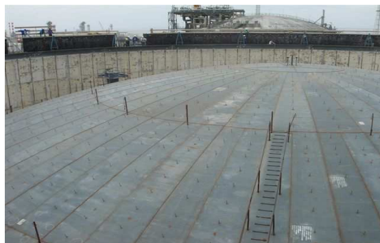
Raccordement toit (position haute)
