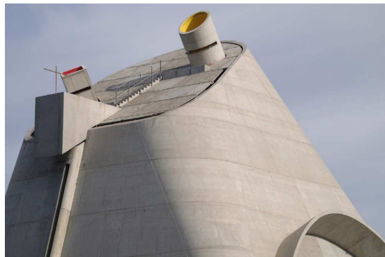
Façade Ouest de l'Eglise vue de l'extérieur
