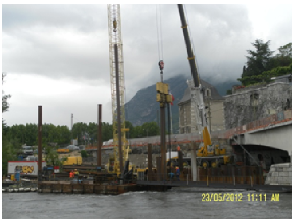
Figure 15 : Mise en place de palplanches par vibro-fonçage (présentation PPT d'Alexandra COUTAUD JOLY)
