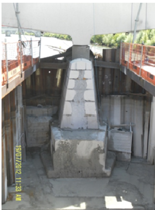
Figure 16 : Vue de l'intérieur du batardeau sur pile découpée avec béton-bouchon mis en place (présentation PPT d'Alexandra COUTAUD JOLY)
