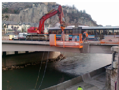
Figure 13 : Démolition de l'encorbellement (présentation PPT d'Alexandra COUTAUD JOLY)
