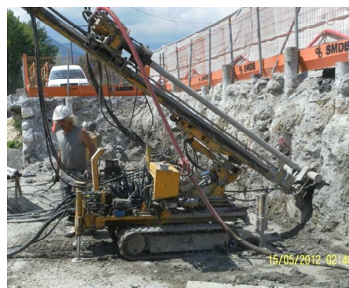
Figure 17 : Renforcement du soutènement en «jet-grouting» par la mise en place de tirants
