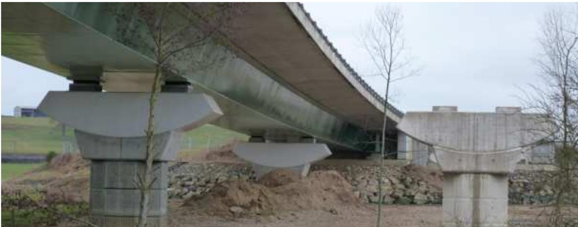
L'ouvrage, d'une longueur totale de 206 mètres avec 5 travées de 32 à 52 mètres, est constitué d'un tablier en caisson mixte de hauteur constante reposant sur des piles et culées fondées sur pieux.
