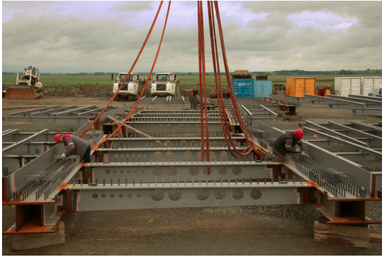
Tablier – Charpente métallique
