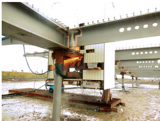
Montage sur site
