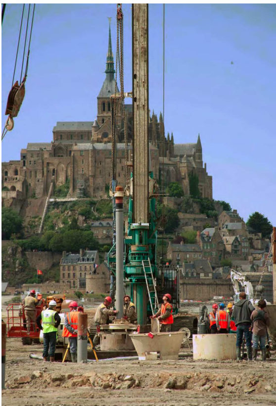
Réalisation des pieux – Mise en place des poteaux
