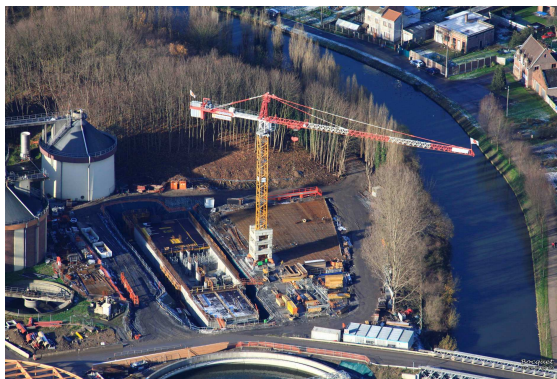
Zone de séchage des boues
