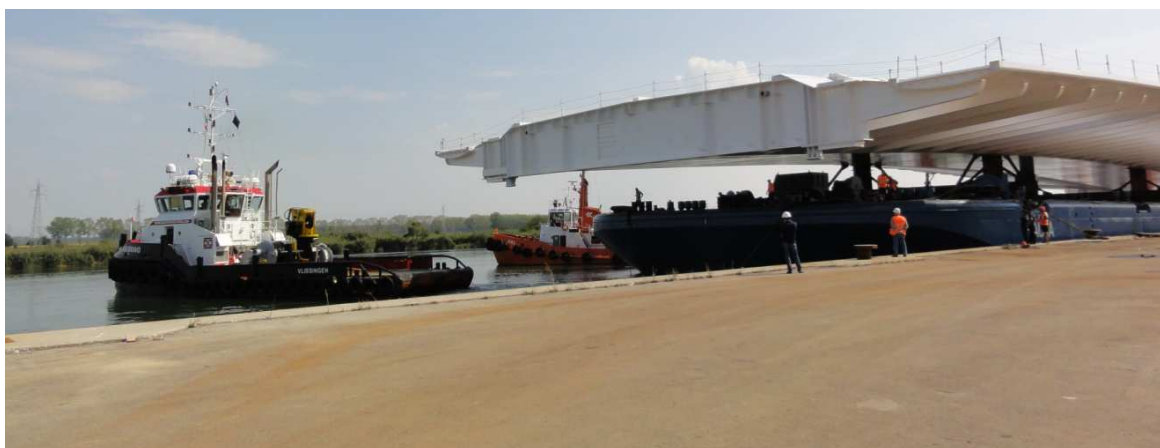
La travée levante à bord et tout est prêt pour le dernier voyage
