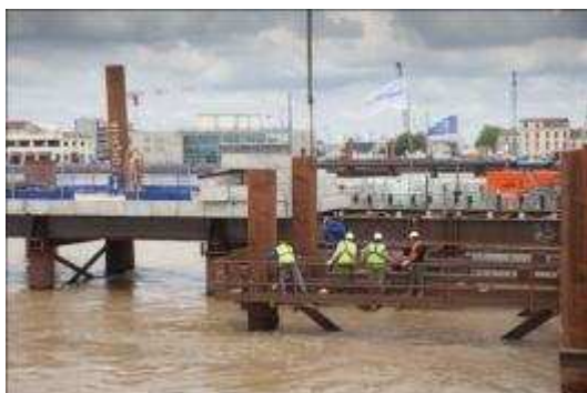
Réalisation du batardeau
