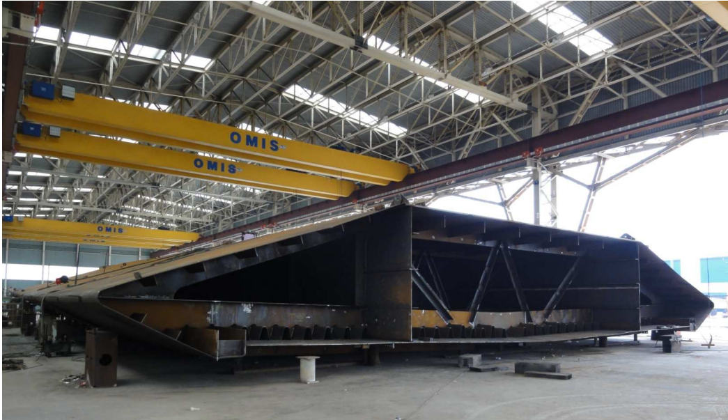
Tronçons du caisson central – Fabrication et assemblage-
