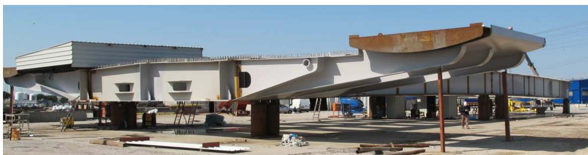
Assemblage sur le quai de l'ossature principale et des éléments en encorbellement
