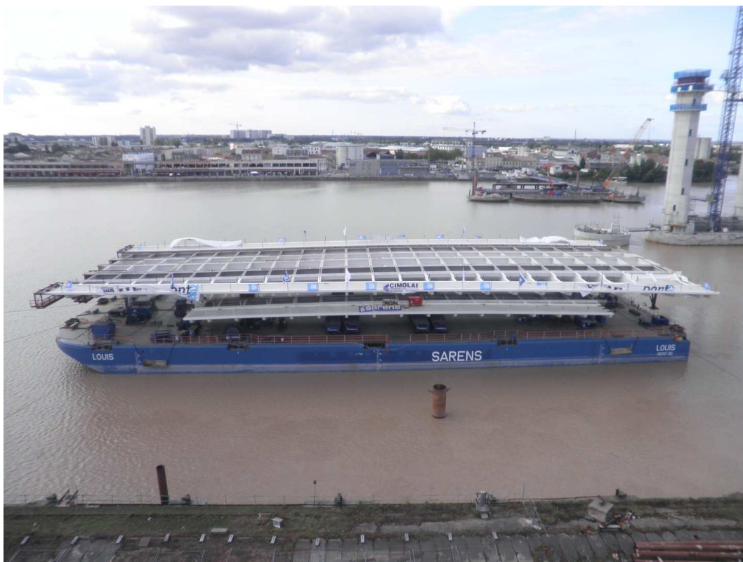
Mise en place de la travée d'accès Rive Droite sur site à Bordeaux
