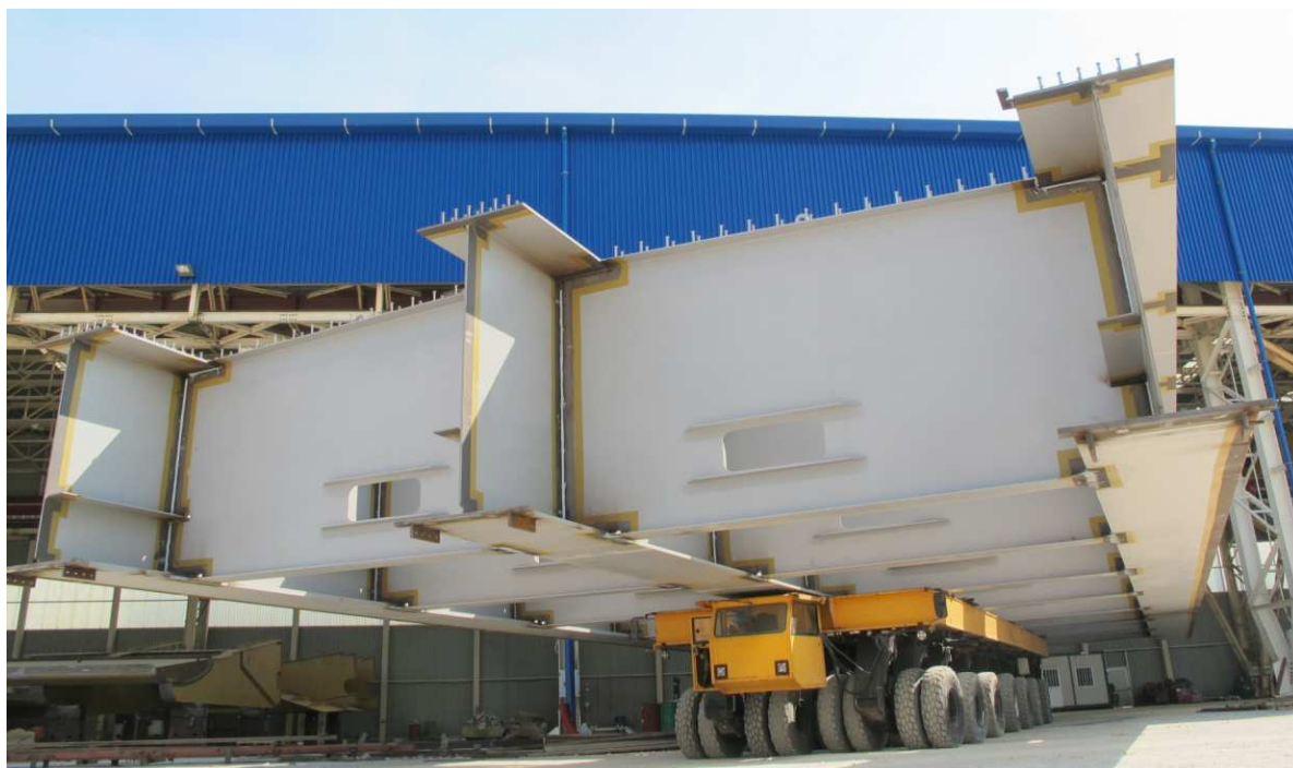
Tronçons de l'ossature métallique principale – Fabrication et assemblage
