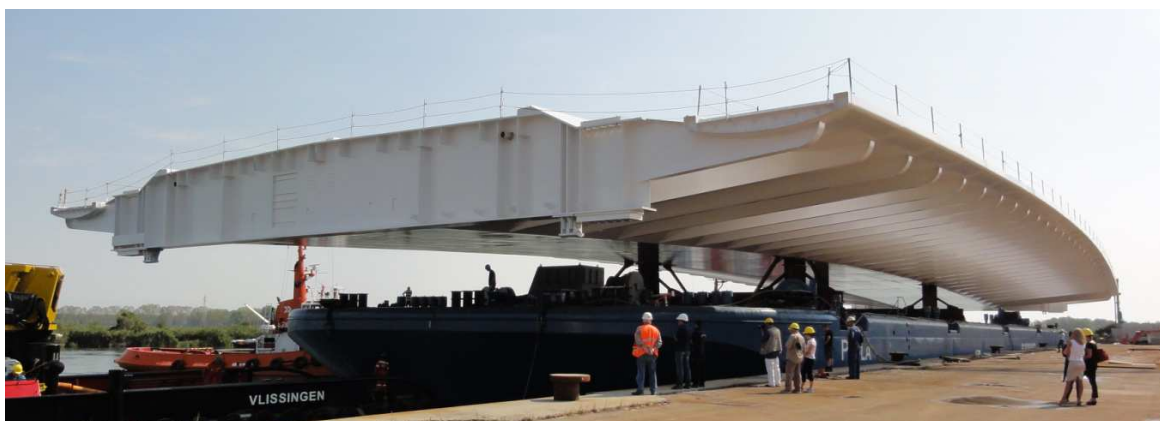
Chargement sur barge
