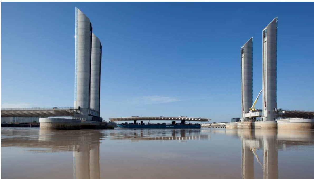
Mise en place de la travée levante sur site à Bordeaux
