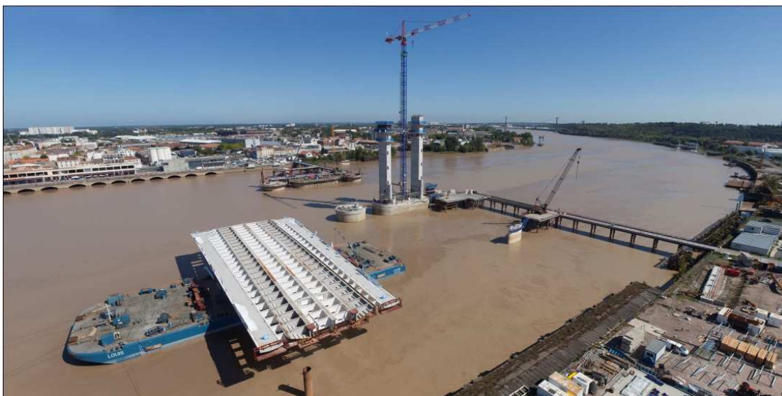
Pose des travées d'accès
