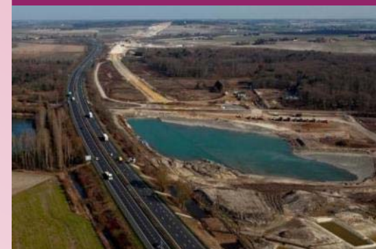
Base Travaux de Nouâtre-Maillé
