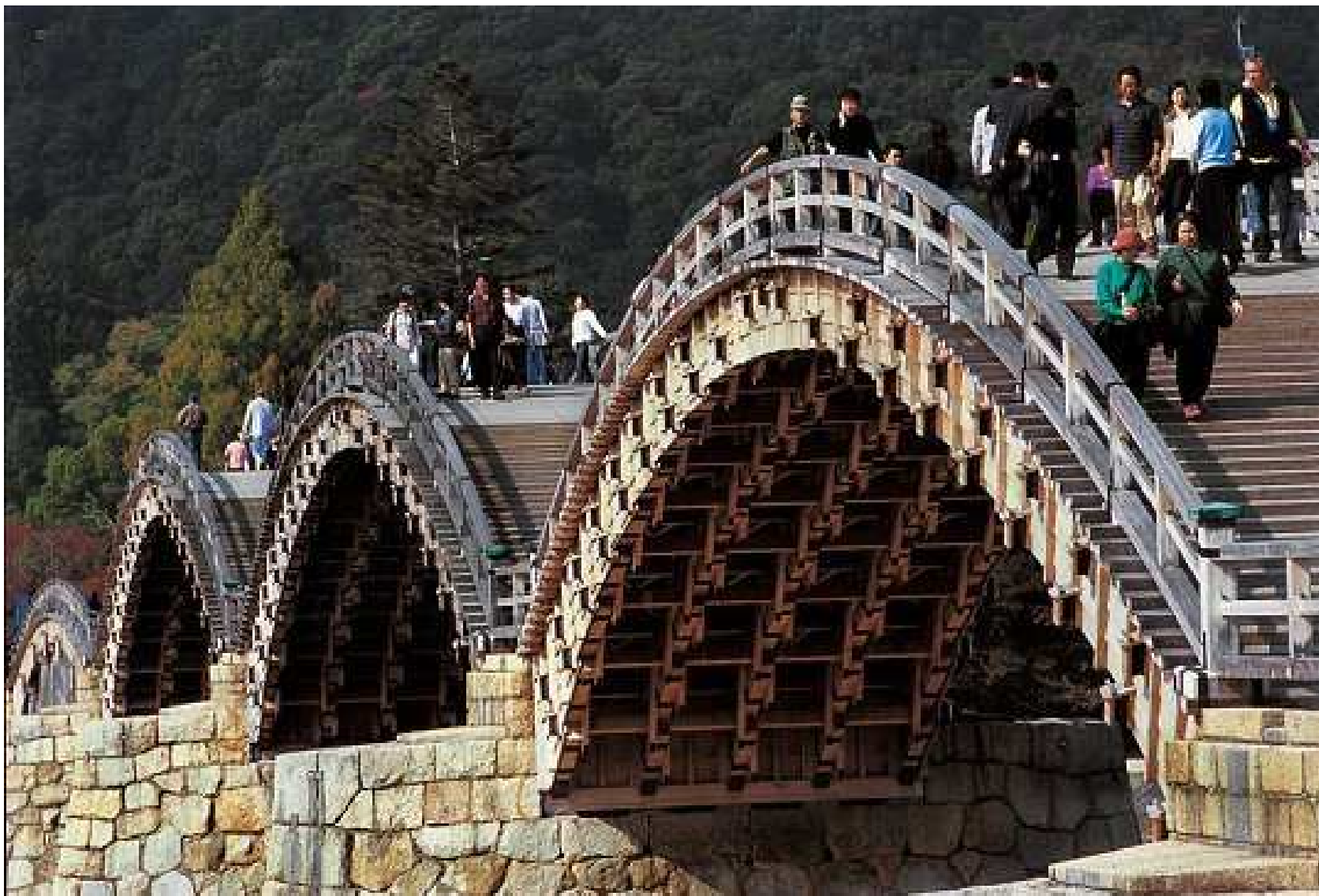
Passerelle de Kintai Japon, 1674, 1953
