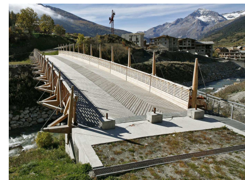
Vue du platelage
