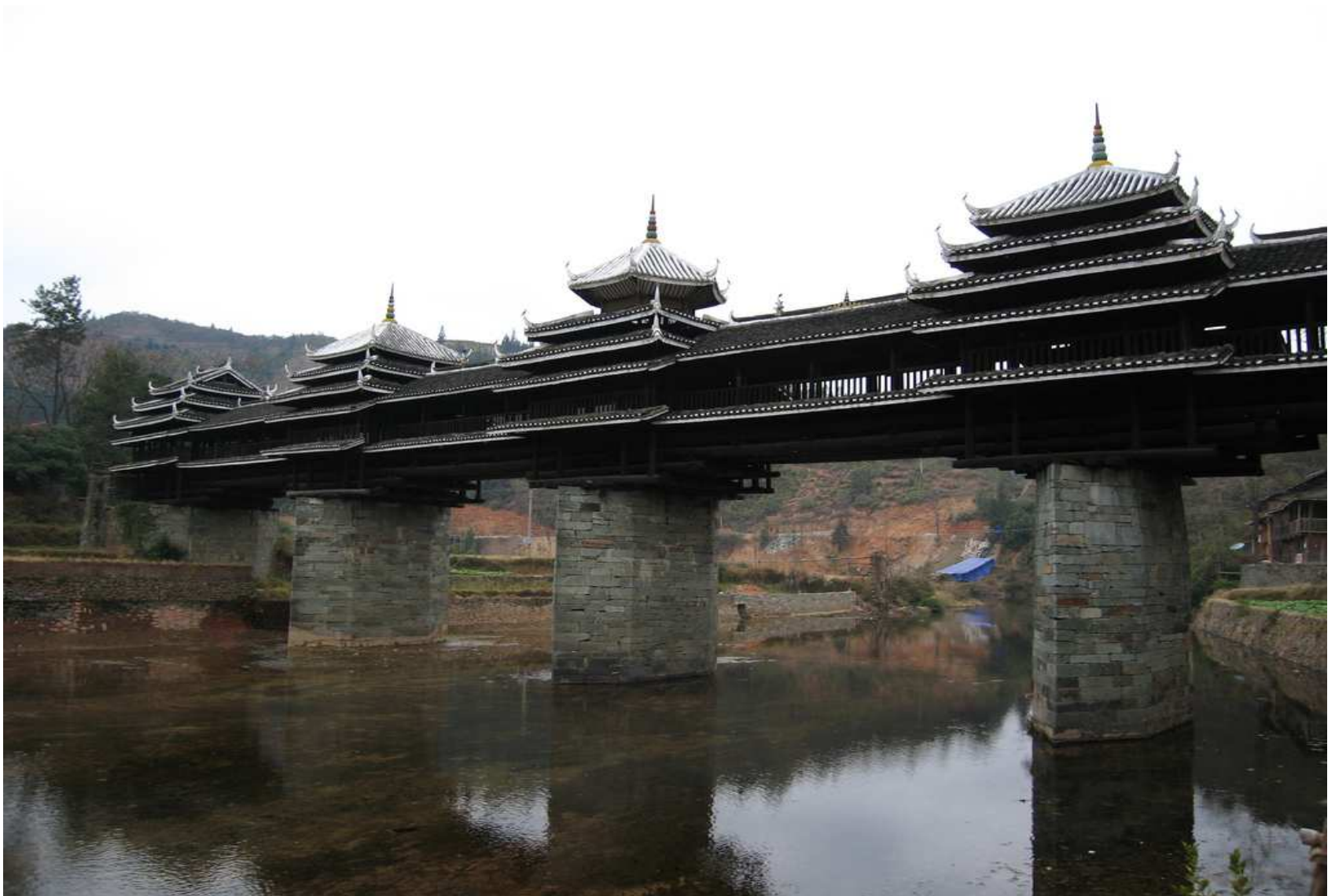
Passerelle de Chengyang Chine, 1918
