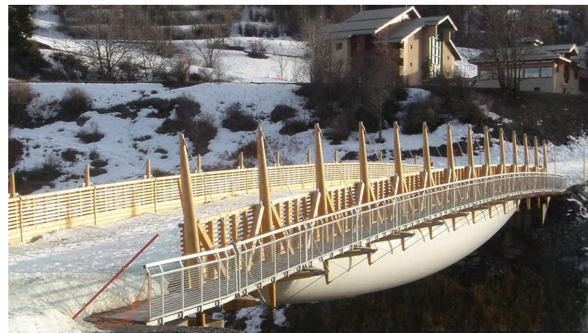
Vue générale du tablier. Les mâts haubanés portent la partie piétonne
