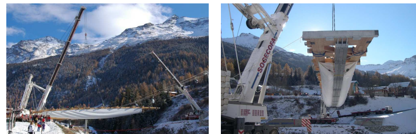
Vues des opérations de levage
