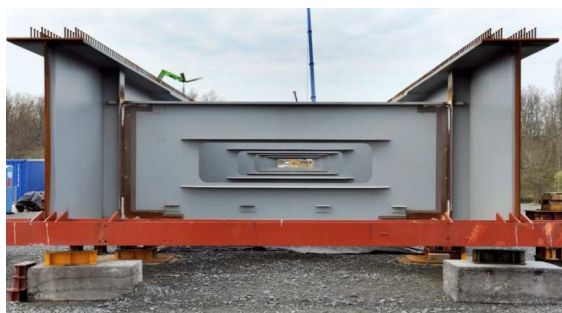
Les travaux de réalisation des piles du Viaduc de la Saye se terminent. Les poutres de la charpente
