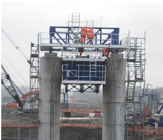
Piles à terre : Coffrages spécifiques
