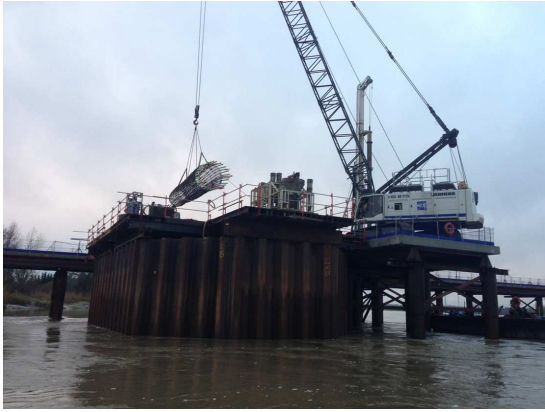
Plateforme de forage des pieux
