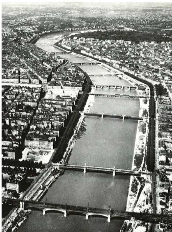
Figure 11 : Les ouvrages sur le Rhône à Lyon
