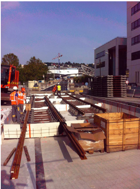
Figure 6 : Construction de la voie ferrée
