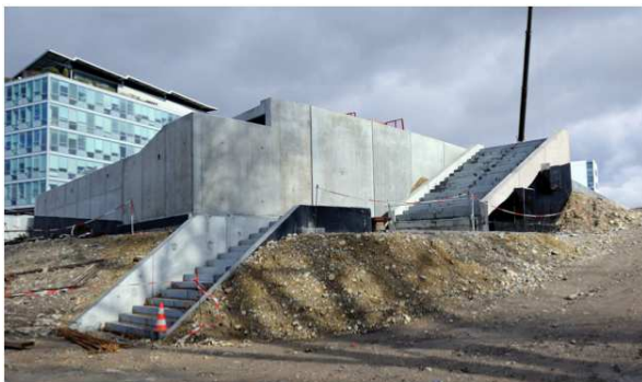
Figure 33 : Culée C3, rampe et accès
