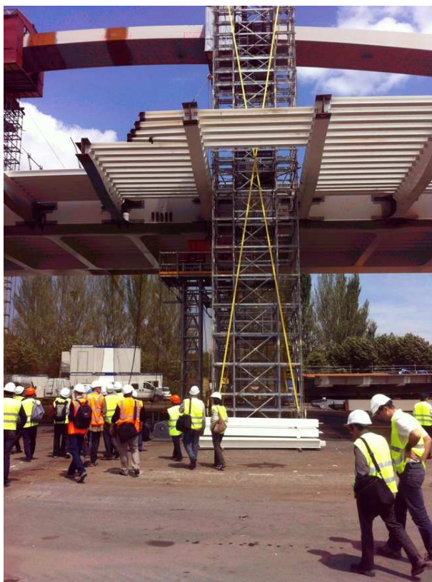
Figure 2 : Visite du chantier de montage
