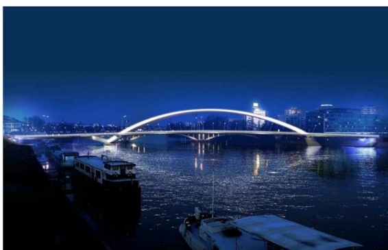
Figure 23 : Mise en valeur du pont par l'éclairage
