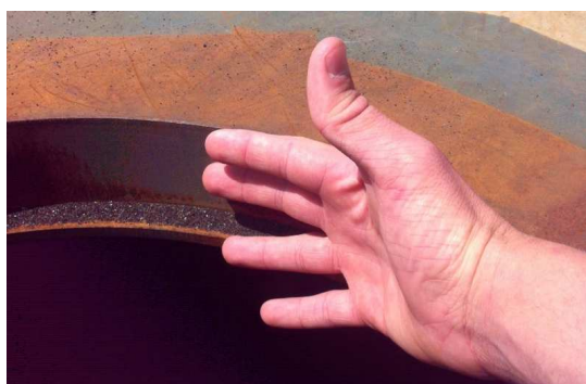
Figure 39 : Image donnant une idée des épaisseurs des caissons métalliques
