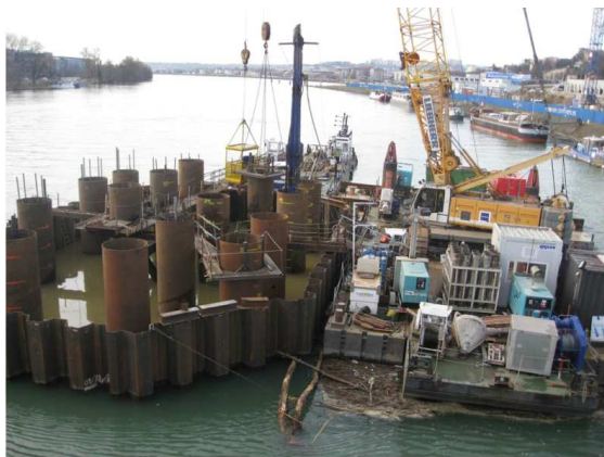
Figure 31 : Construction de la pile P1 à l'aide de batardeaux. Installation des pieux
