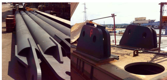
Figure 38 : Butons provisoires avant d'être montés et oreilles de montage des butons
