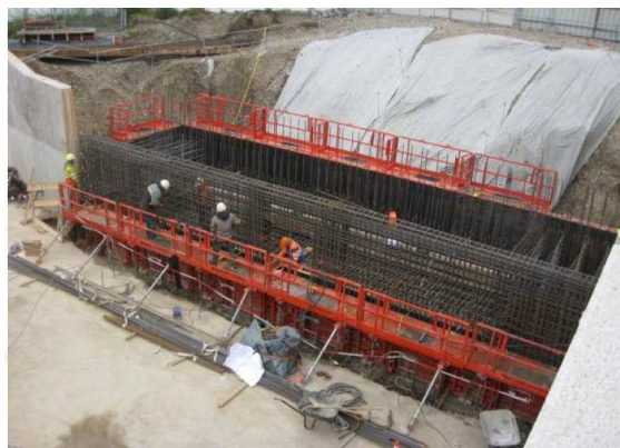
Figure 30 : Ferrailage de la Culée C0 à proximité immédiate du pont Pasteur
