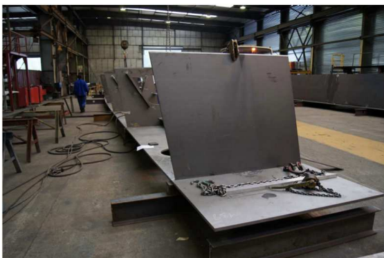
Figure 35 : Fabrication en usine d'un caisson. Mise en place d'un diaphragme
