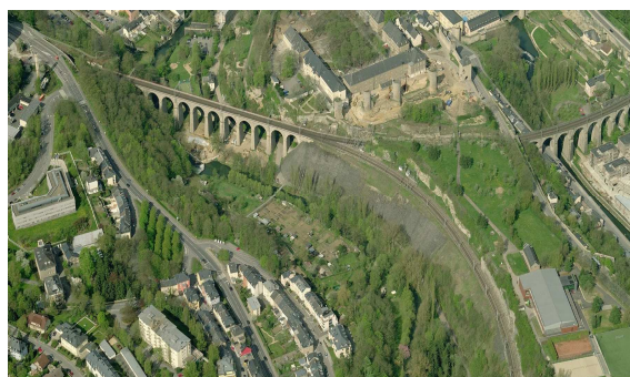
Site du nouveau viaduc de Pulvermühle
