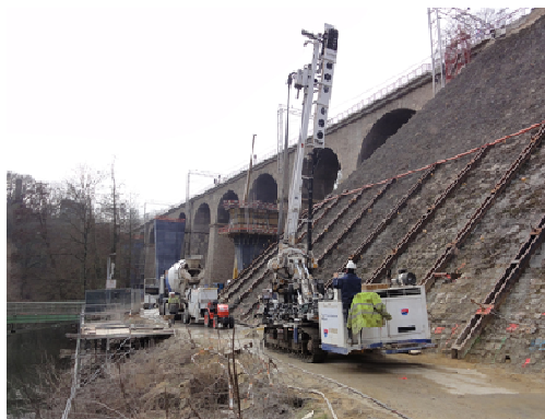
Travaux d'injections
