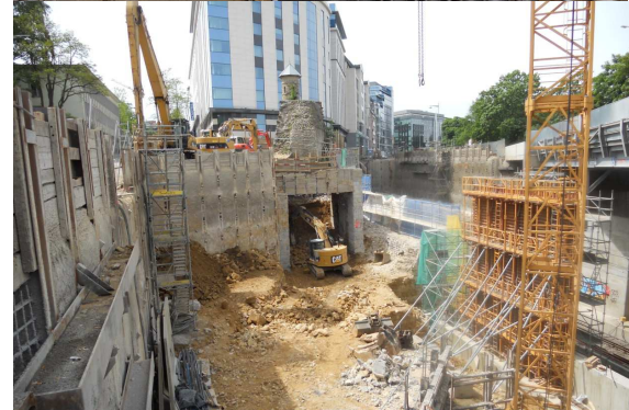
Stabilisation de la tourelle espagnole
