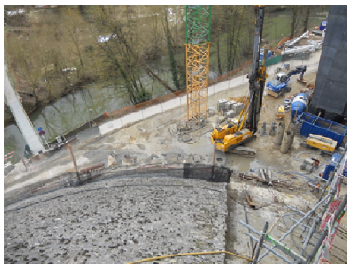
Travaux de pieux métalliques
