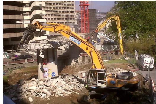
Démolition de la passerelle
