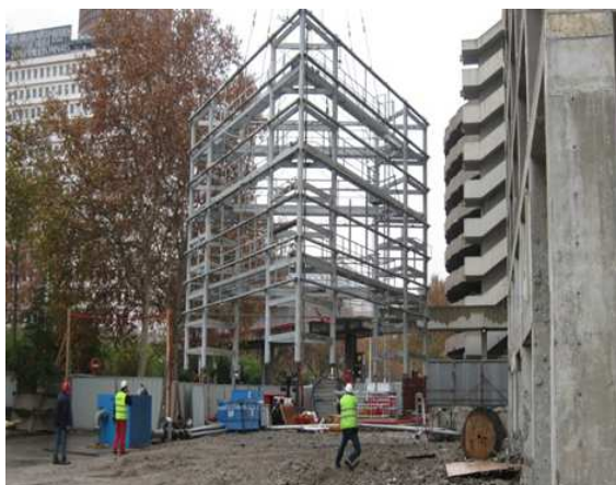
Traitement de la structure métallique
