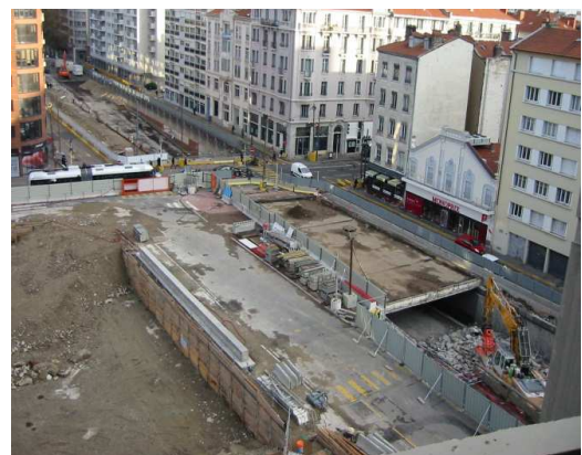
Démolition de la dalle de couverture par grignotage
