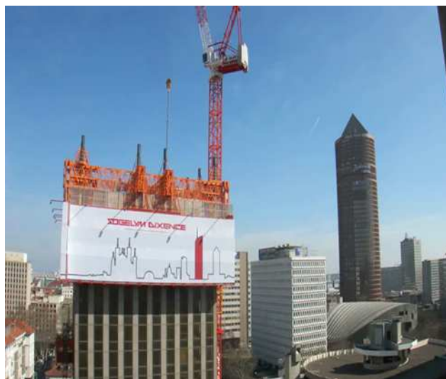
Coiffe de déconstruction de la tour UAP
