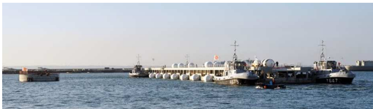
fig. 18 – arrivée du caisson à son emplacement définitif (1)
