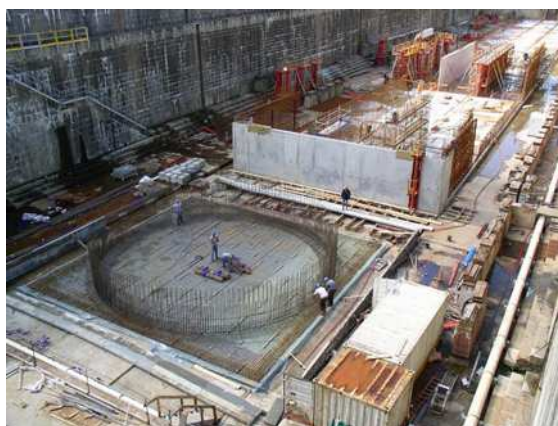
fig. 8 – construction du musoir – dalle de fond
