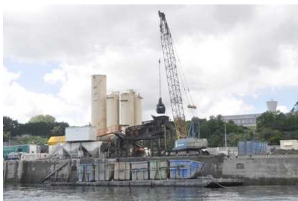
fig. 13 – centrale de traitement des boues de dragage
