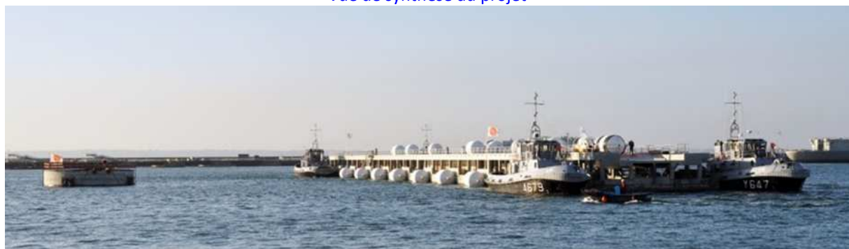
Arrivée du caisson à son emplacement définitif
