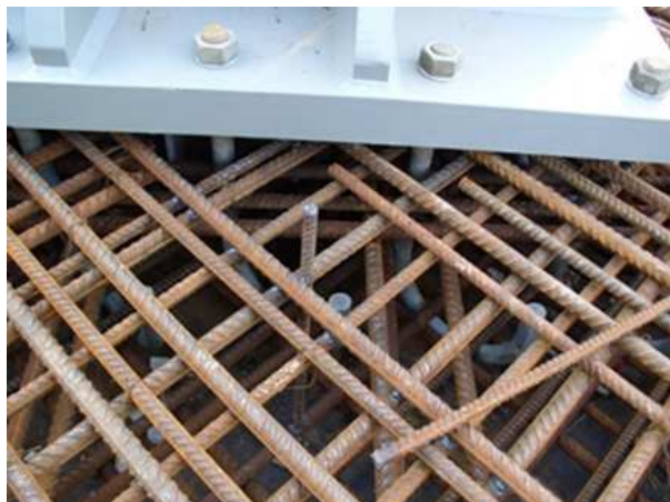
fig. 12 – détail de ferrailage d'ancrages
