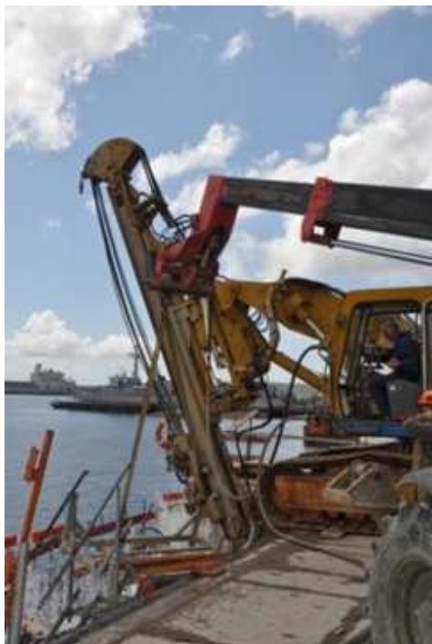
fig. 14 – réalisation des micro-pieux
