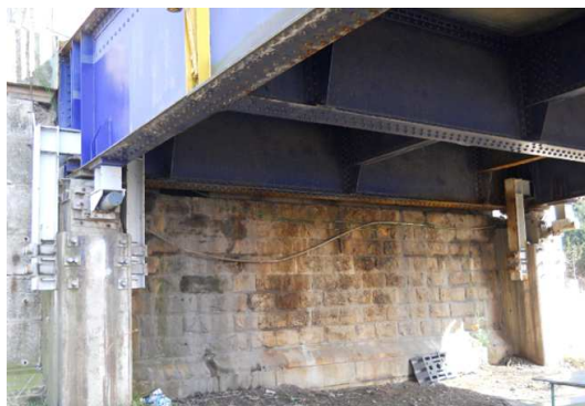
Appareils d'appui changés en 2006
