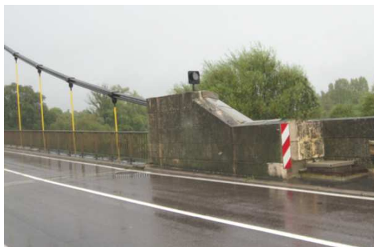
En hiver, les 4 chambres d'ancrage sont chauffées
