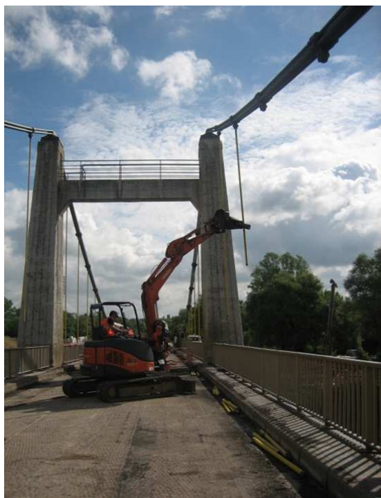
Dépose des câbles porteurs sur les tirants des piles (mi-juin 2013)
