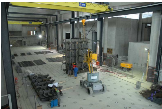
Vue de la plate-forme d'essais des structures, hourdis supérieur achevés, pose de la peau coffrante du mur de réaction en cours.
