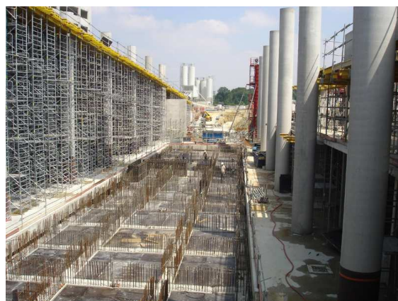
Vue du radier de la plate-forme d'essais des structures avec aciers des raidisseurs en attente.
