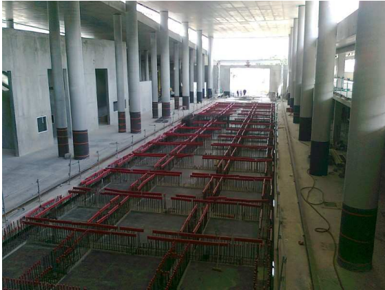
Vue de la plate-forme d'essais des structures avant coulage du hourdis supérieur
