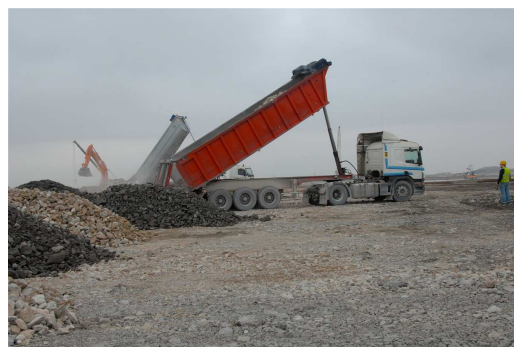
Semi-remorque pour amenée à pied d'oeuvre les enrochements du Boulonnais
