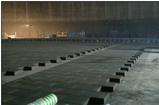
Installation isolation de fond
