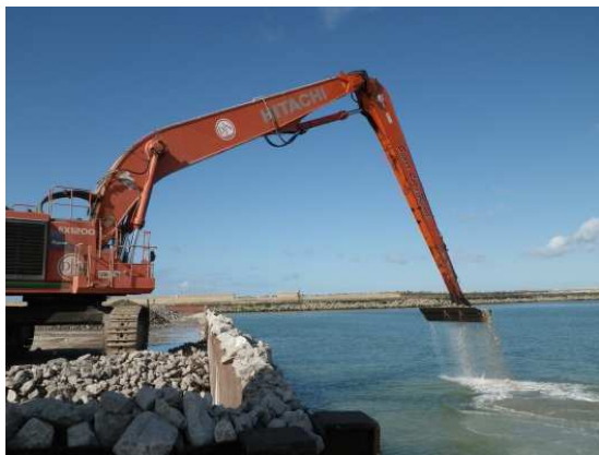
Mise en oeuvre du noyau inférieur et des butées de pied par moyens nautiques
