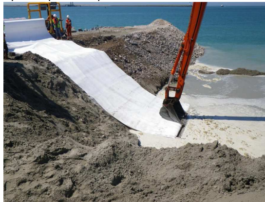
Pose de géotextile intérieur (filtre/corps de remblais en sable)
