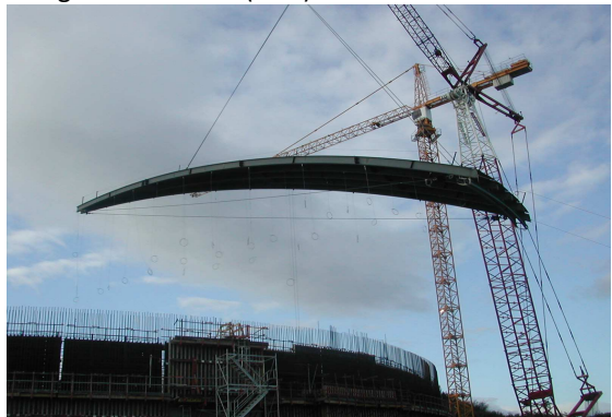
Pose 1 er élément de toit
