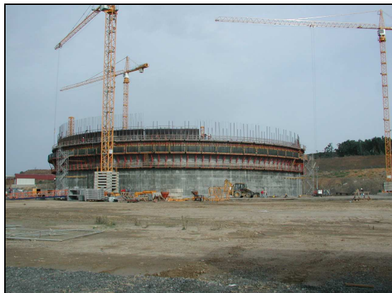
Construction mur béton
