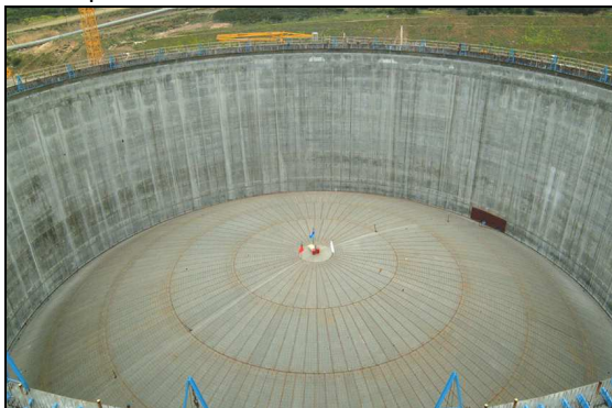
Toit en position basse
