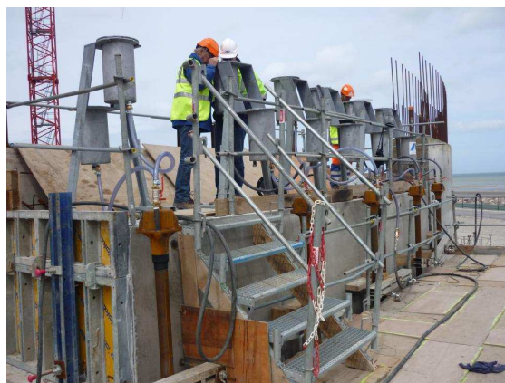
Sommet de la maquette d'injection des câbles verticaux
