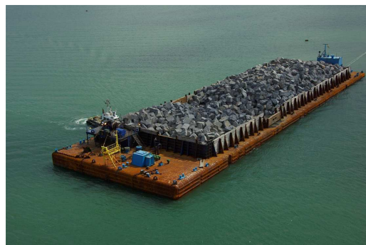
Livraison des enrochements de carapace 5-7 T et 6-10 T par barges de 20 000 T en provenance de Norvège
