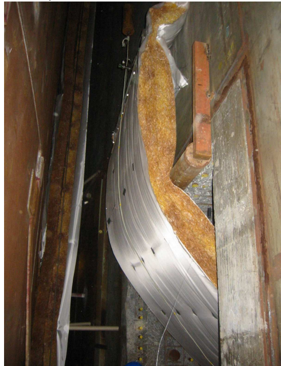
Mise en place isolation
