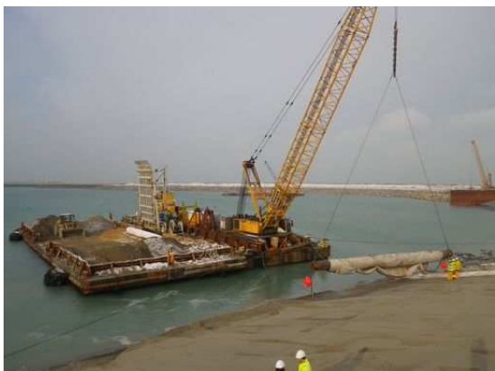
Les protections intérieures - Sur talus en sable à 4/1 ou 6/1
