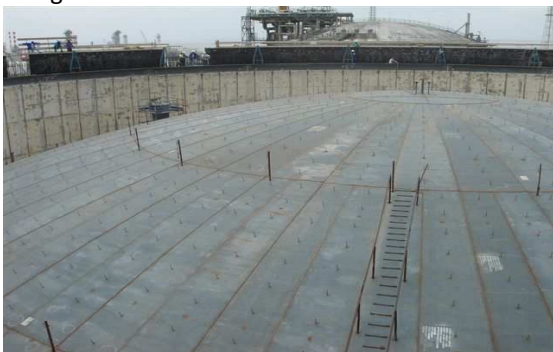
Levage à l'air du toit
