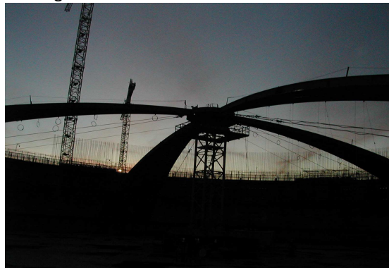
Montage éléments de toit
