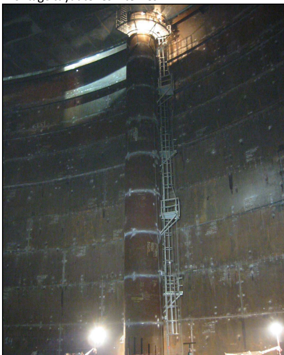
Montage tuyauteries internes
