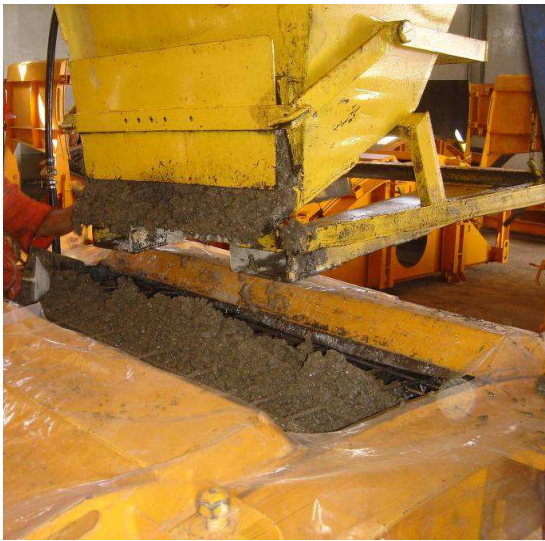
Bétonnage et vibration
