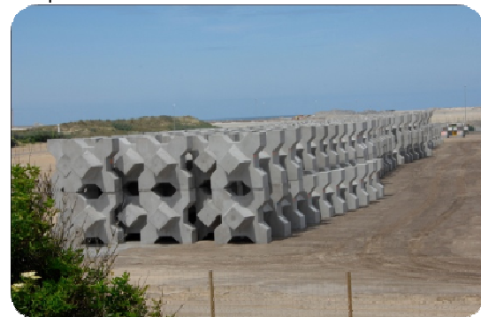
Carapace en blocs artificiels X-Blocs
