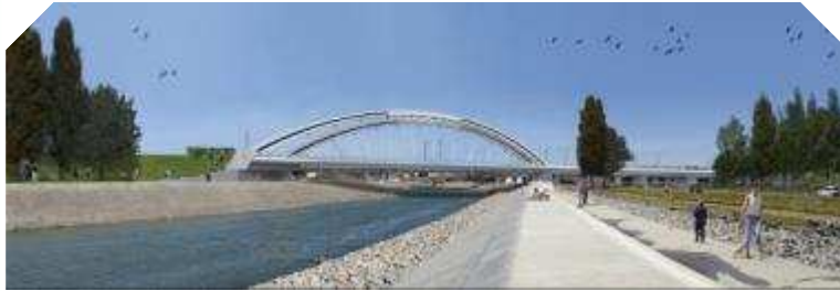
Viaduc du Lez
