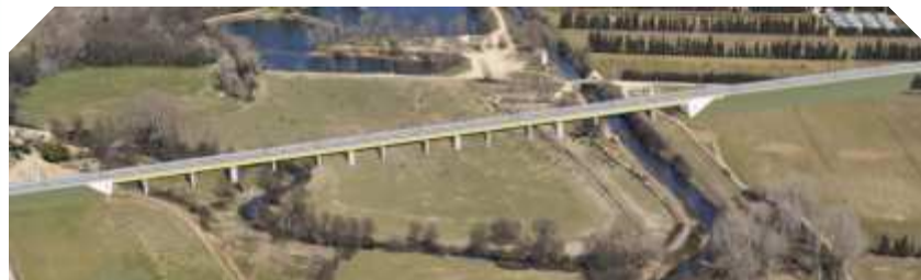
Viaduc du Vistre
