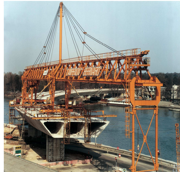
Viaduc de St Cloud, 1973
