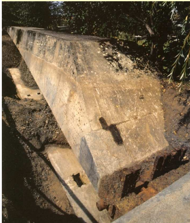
Arche d'essai du Veudre (1907)
