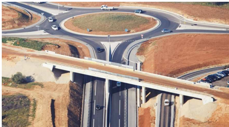
PRA 5 travées au dessus de la RN113
