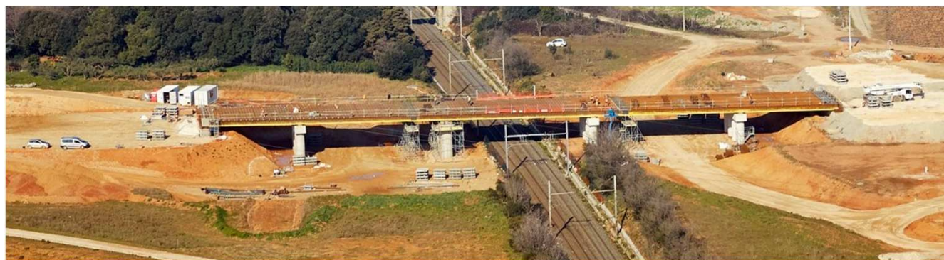
TPE PRA (CNM) au-dessus de la voie ferrée existante Nîmes-Tarascon-Marseille et au droit de la future Gare TGV de Nîmes-Manduel
