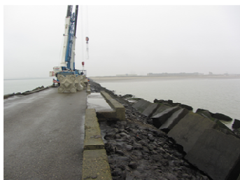
Mise en place des Xblocs IJMuiden – Pays Bas
