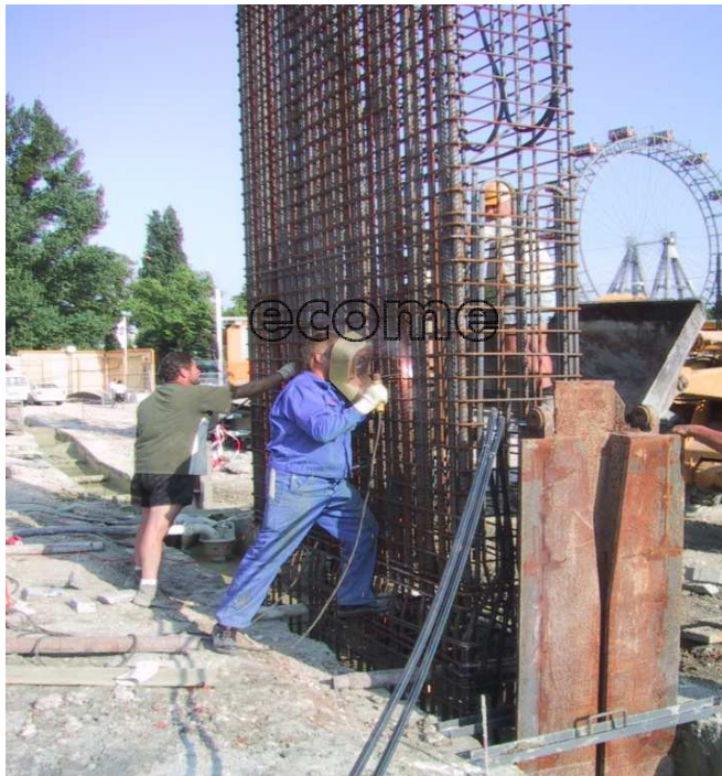
Mis en place de l'armature de la paroi moulée équipée de tubes caloporteurs
