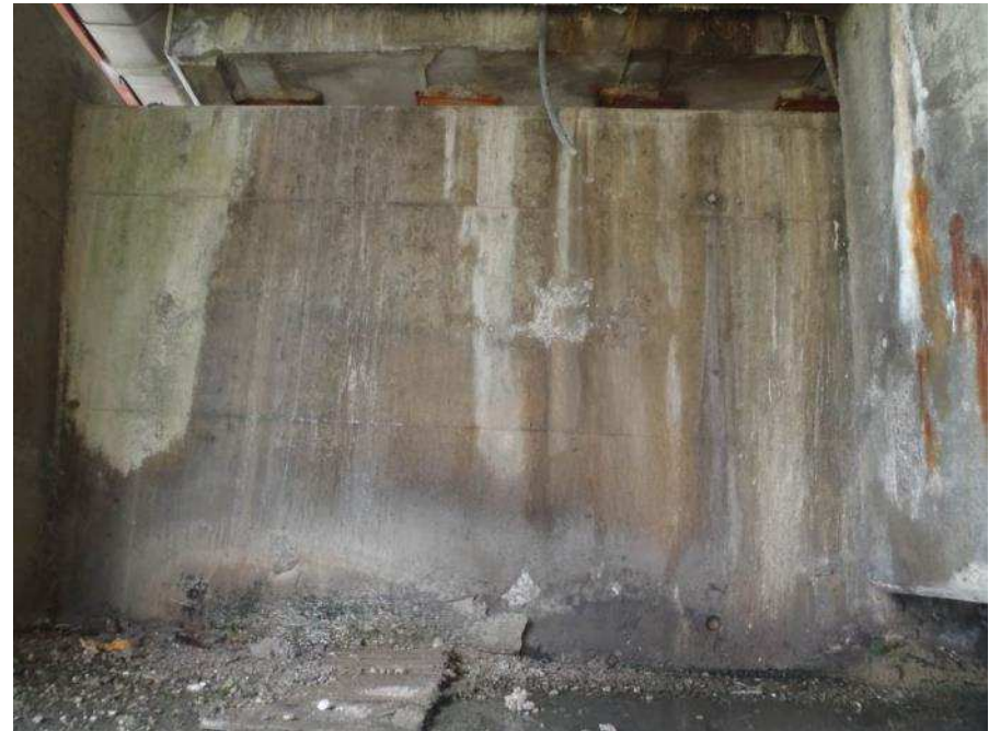
About d'ouvrage – Défauts d'enrobage et d'étanchéité des joints – Photos CG54
