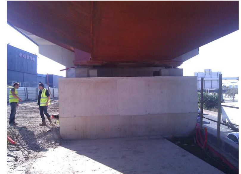
Photo Pile-Culée PC3 sans murets caches
