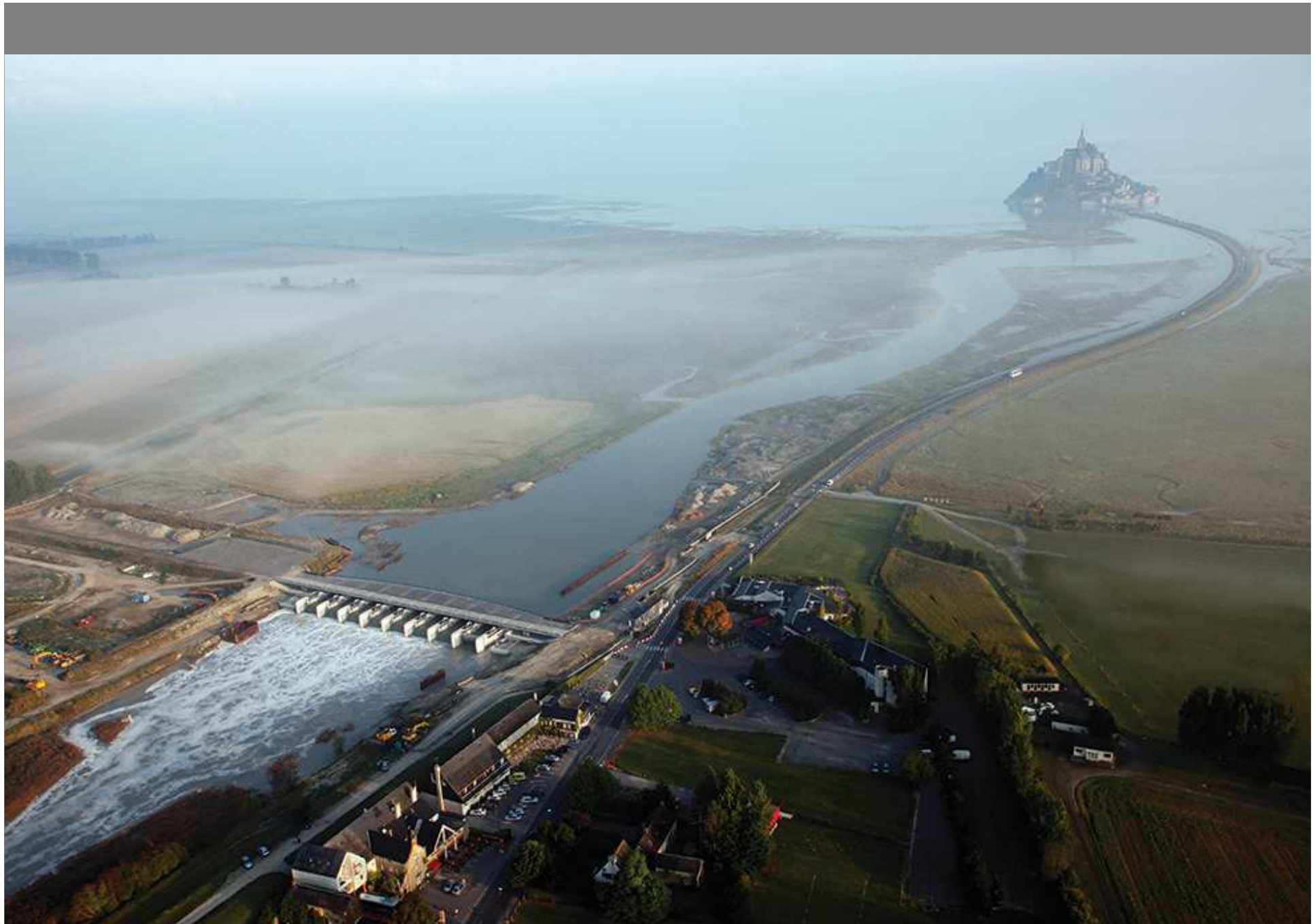
le barrage du Mont Saint-Michel
