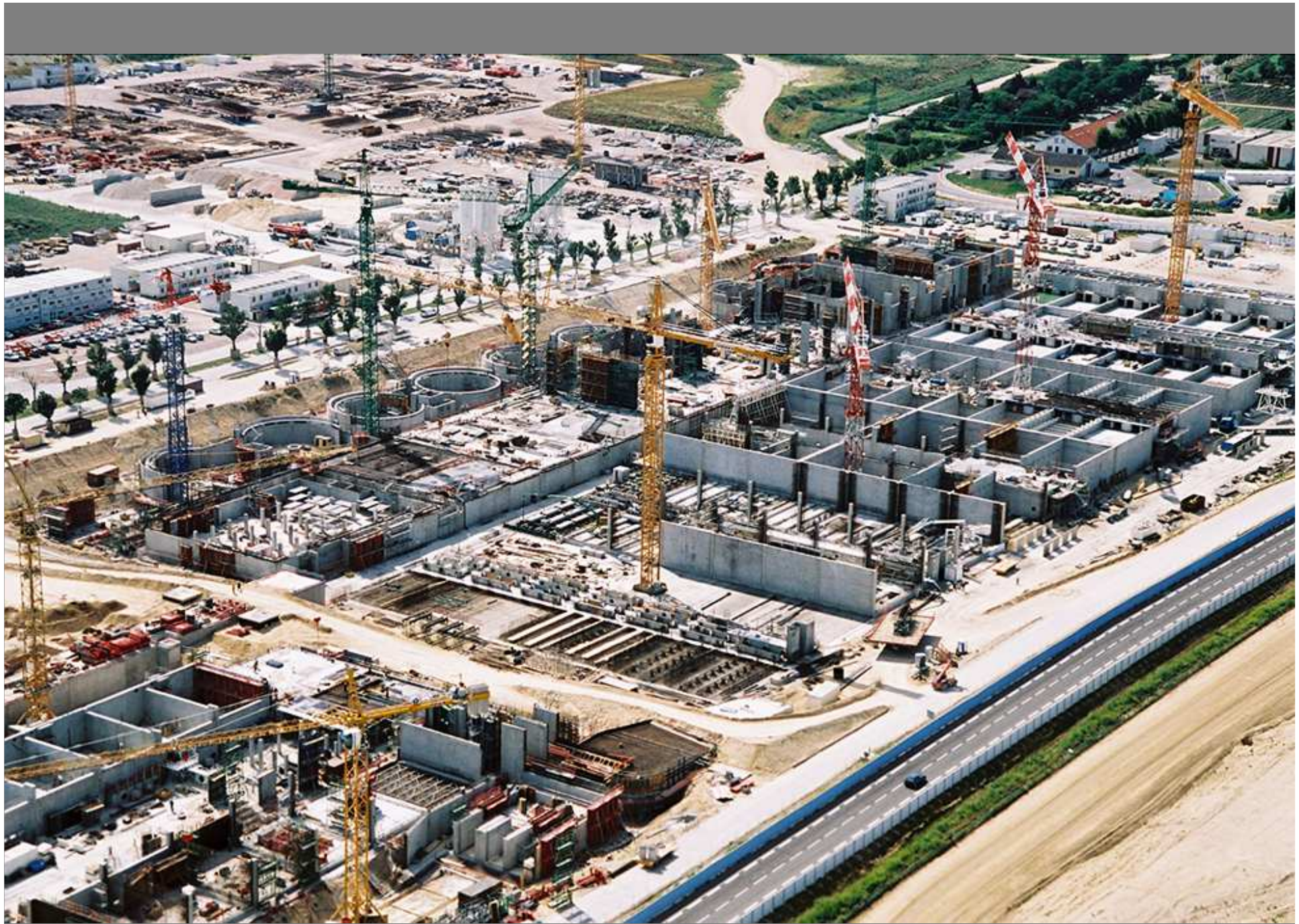
l'unité de traitement des pollutions azotées
