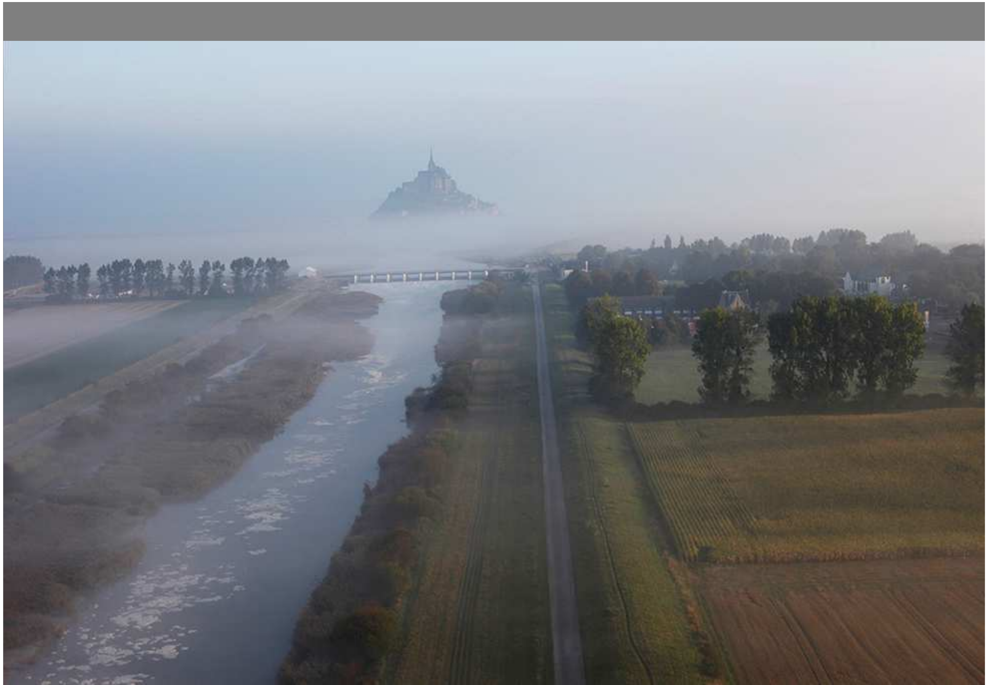
le barrage du Mont Saint-Michel
