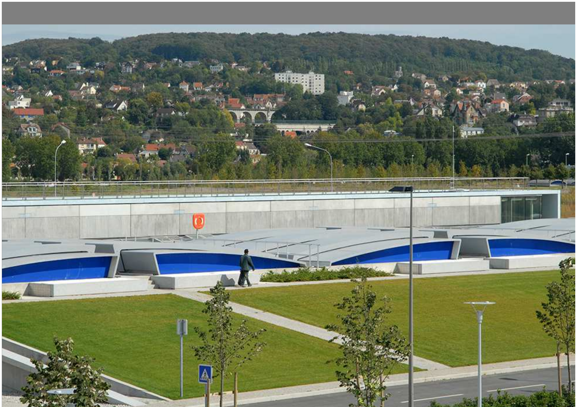
l'unité de traitement des pollutions azotées
