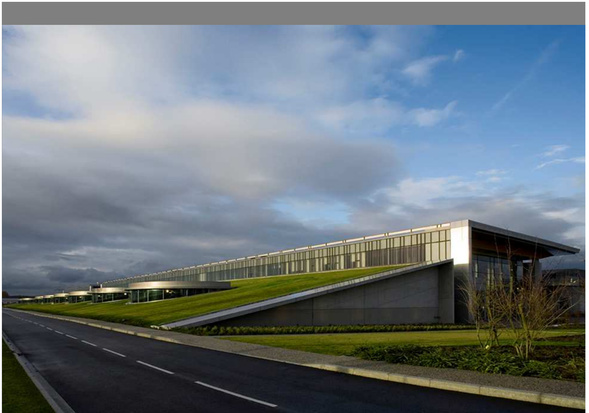
l'unité de traitement des pollutions azotées
