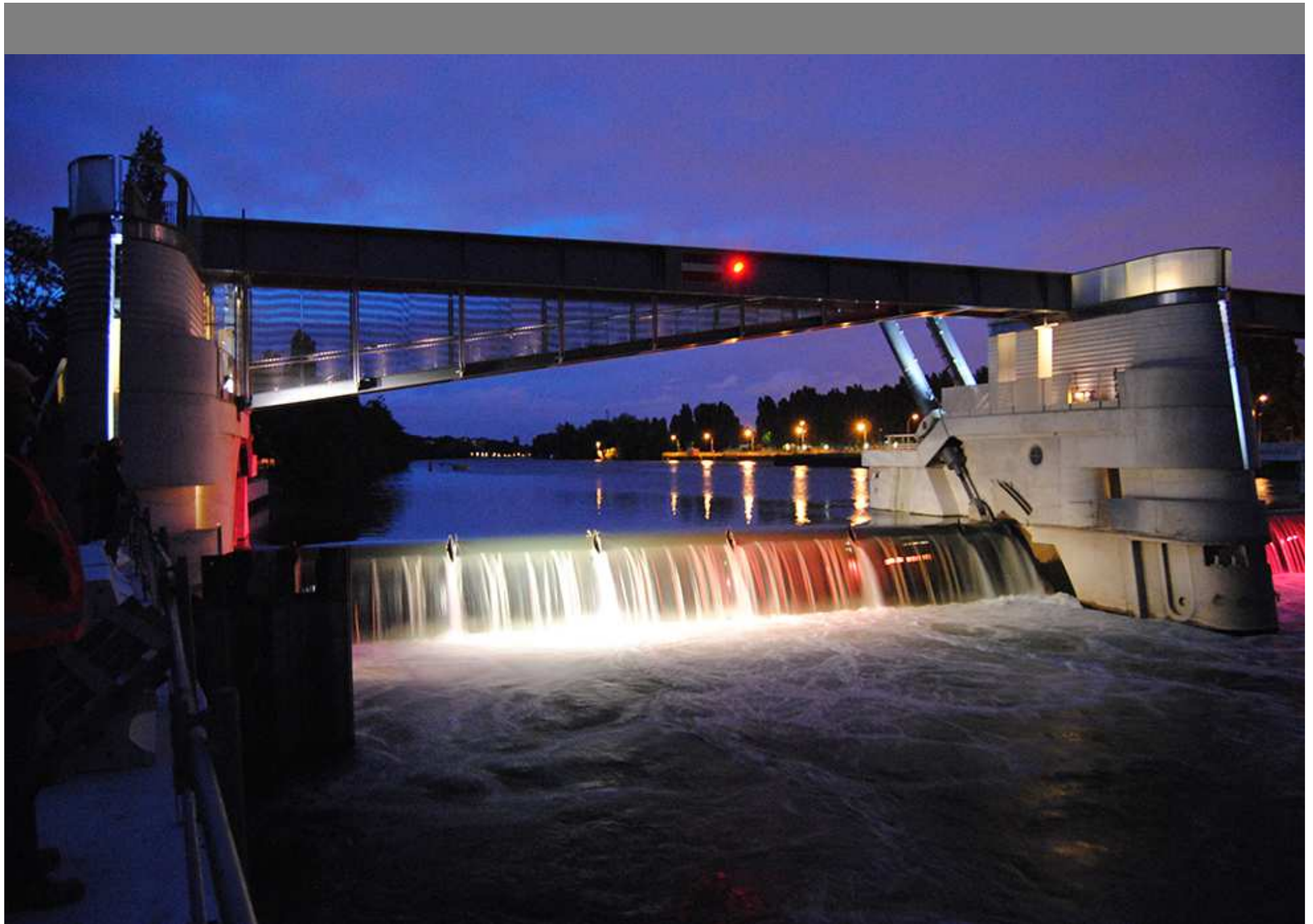
le barrage de Chatou
