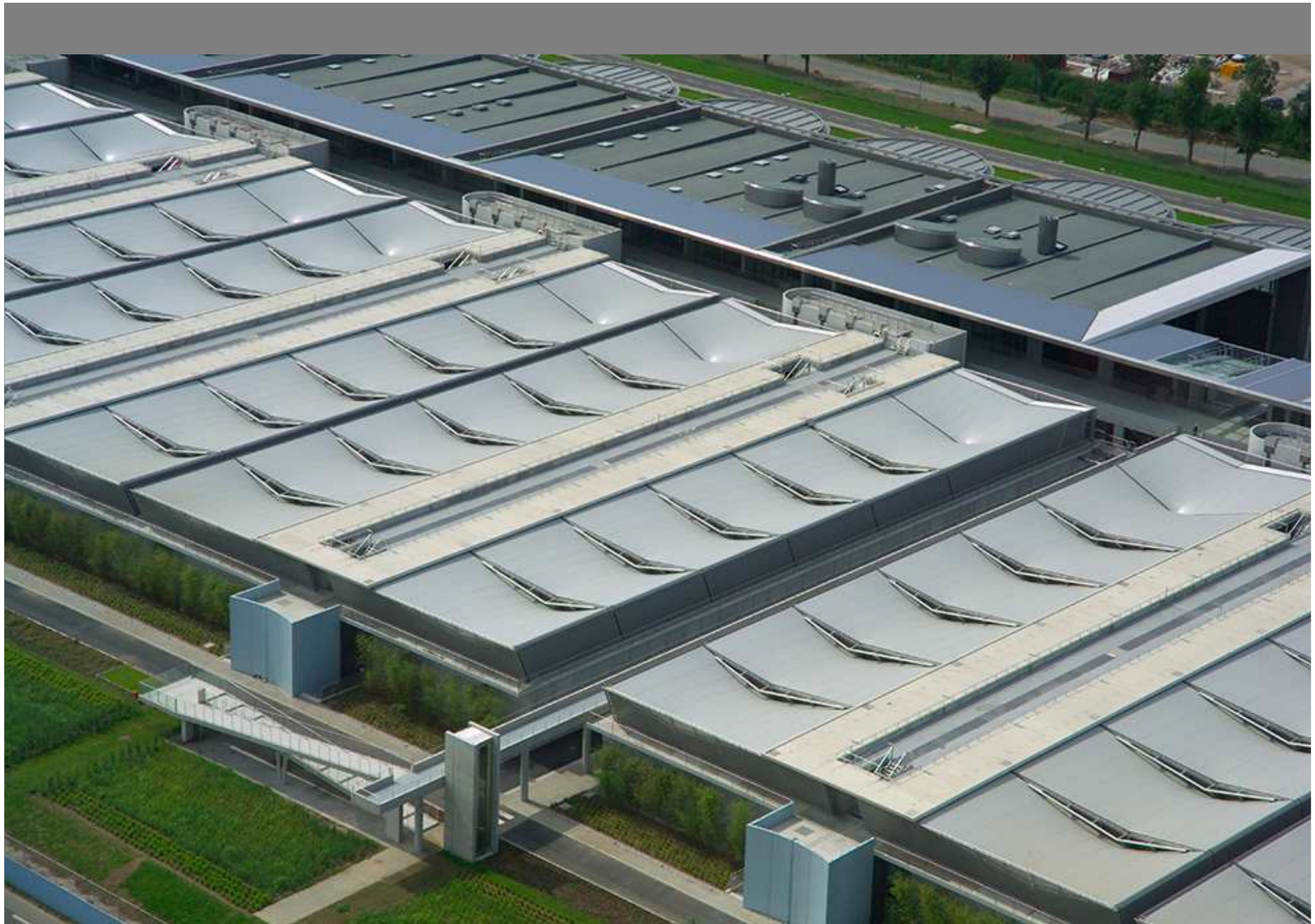
l'unité de traitement des pollutions azotées
