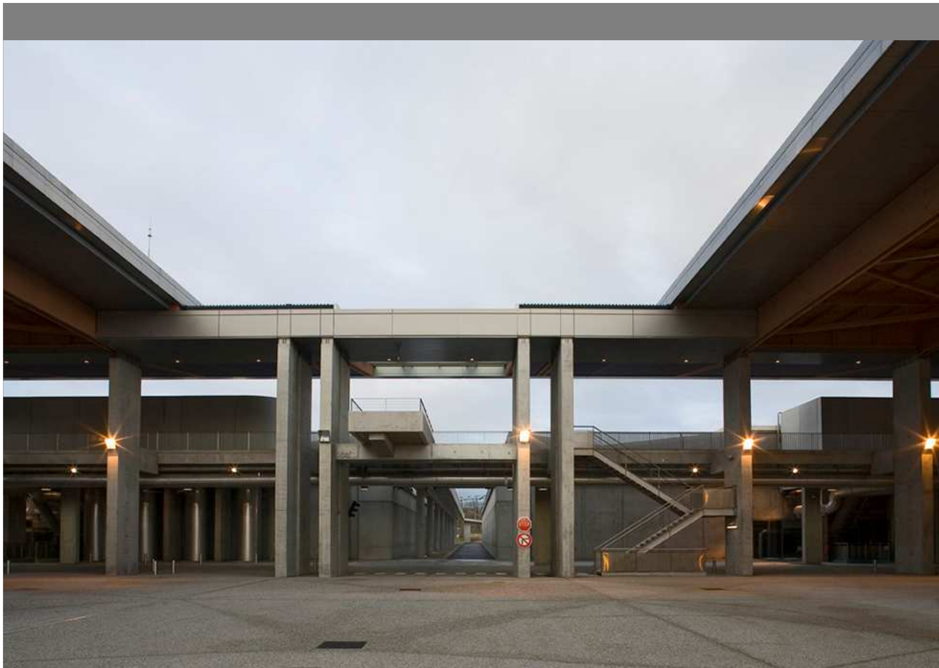
l'unité de traitement des pollutions azotées
