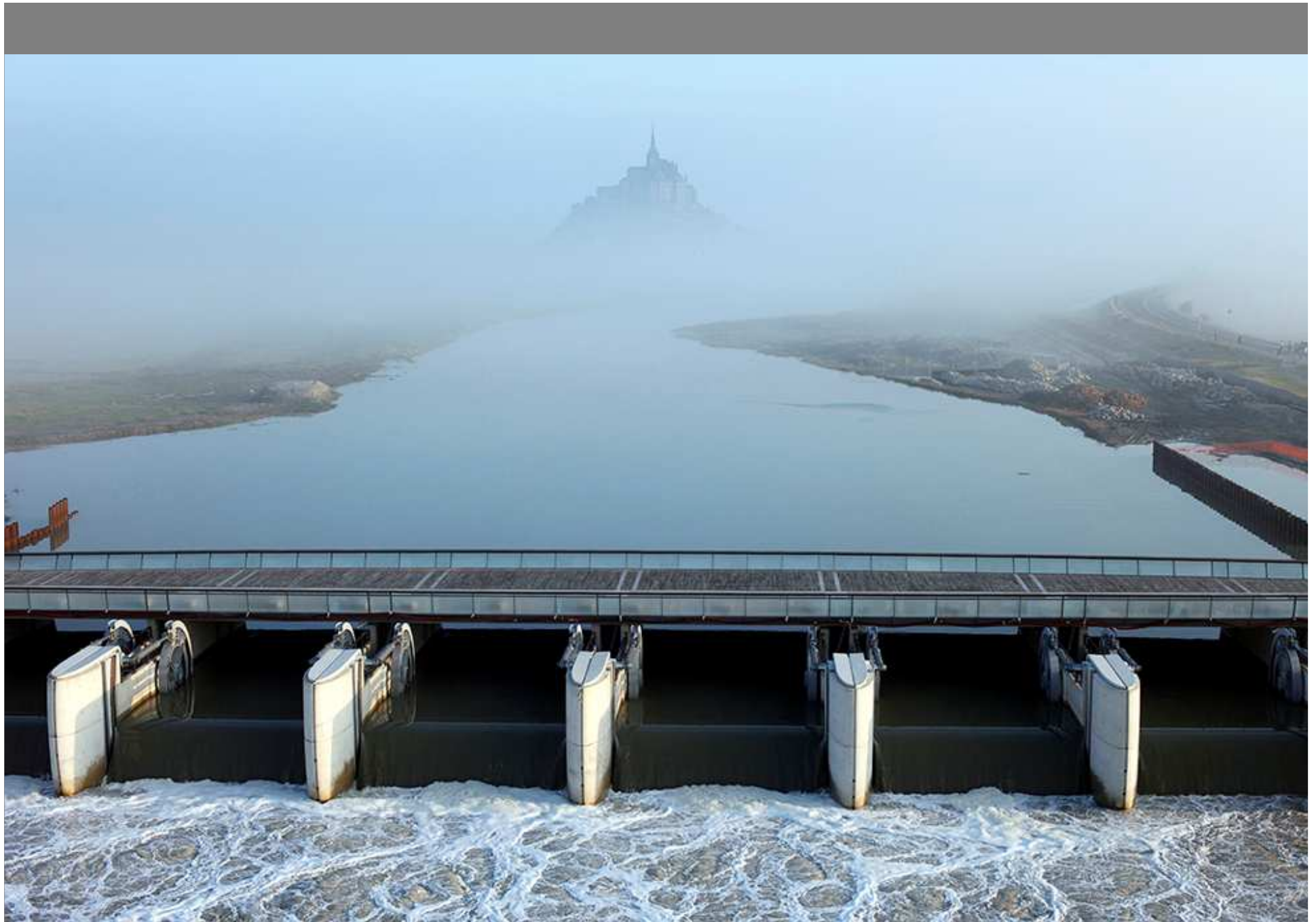
le barrage du Mont Saint-Michel
