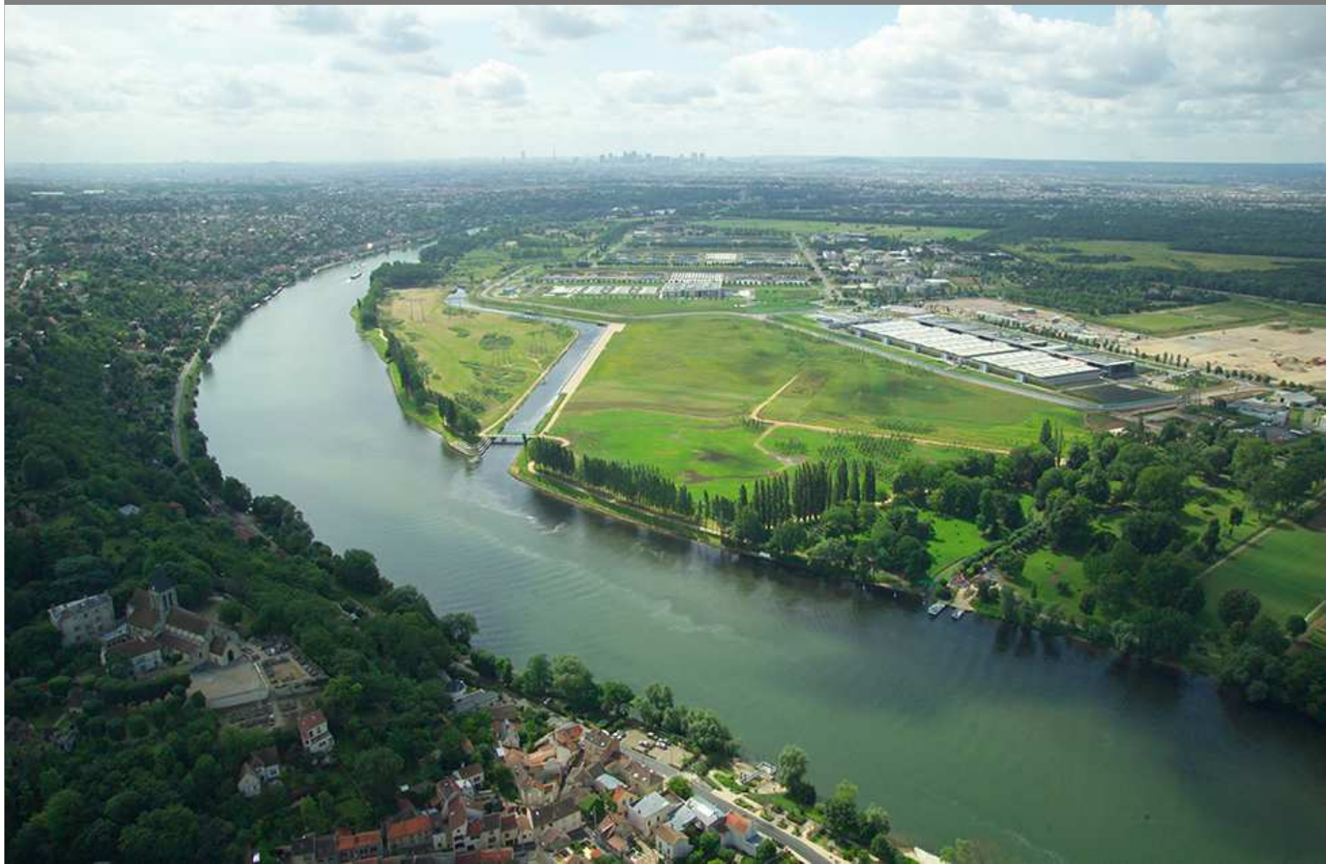
l'unité de traitement des pollutions azotées
