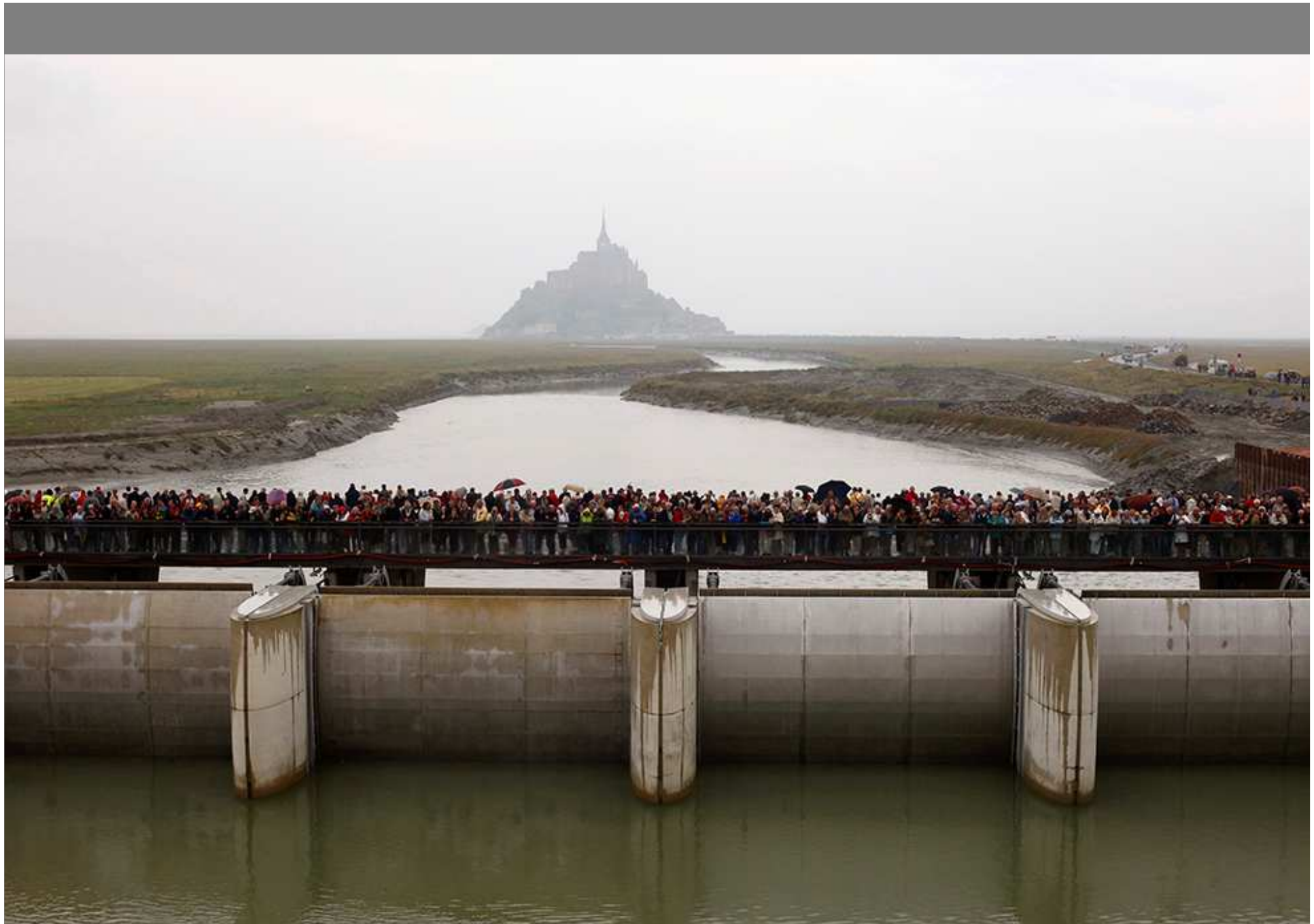
le barrage du Mont Saint-Michel
