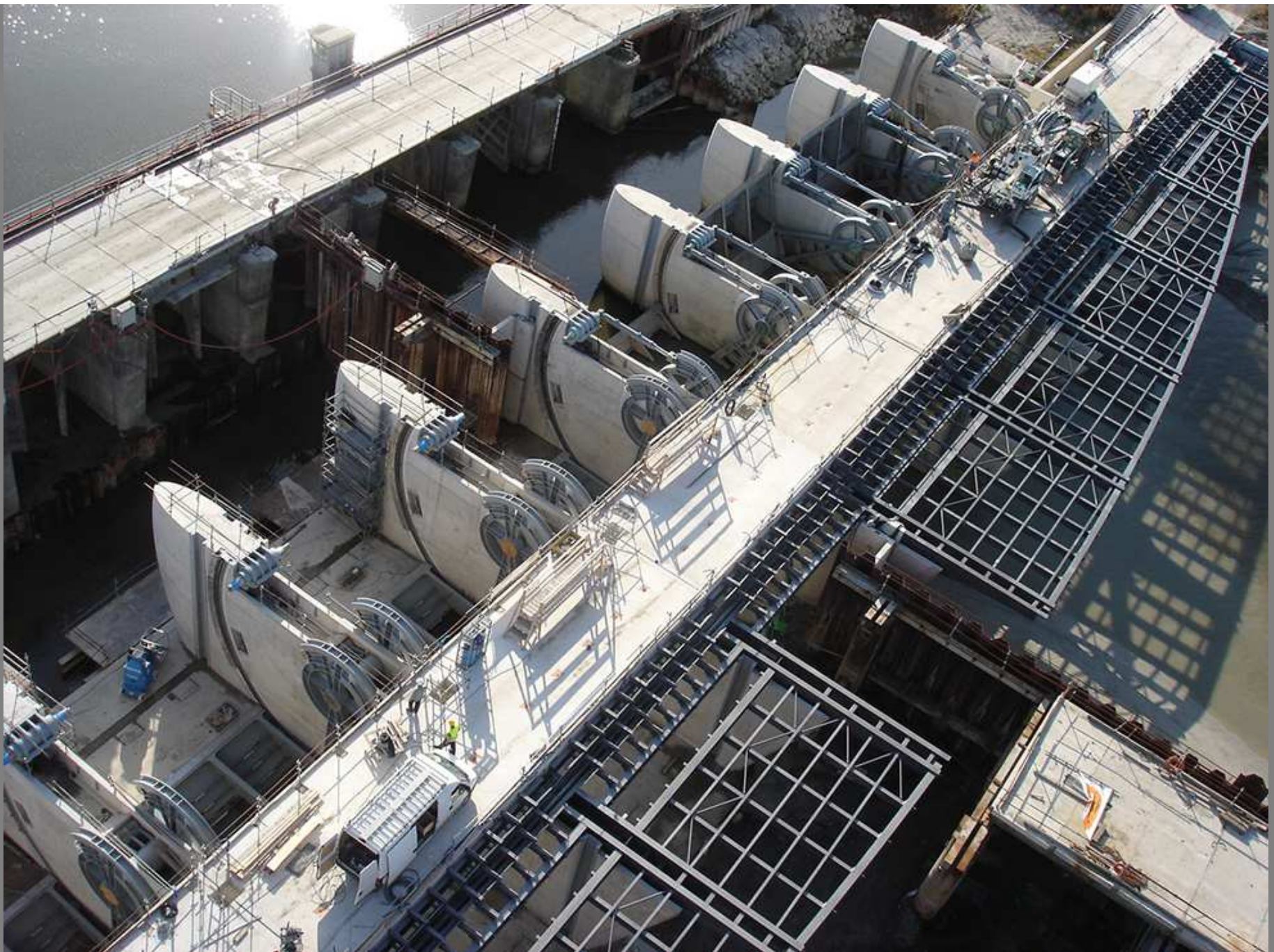
le barrage du Mont Saint-Michel
