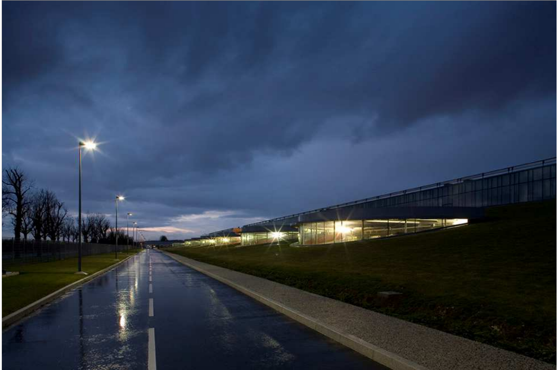
l'unité de traitement des pollutions azotées
