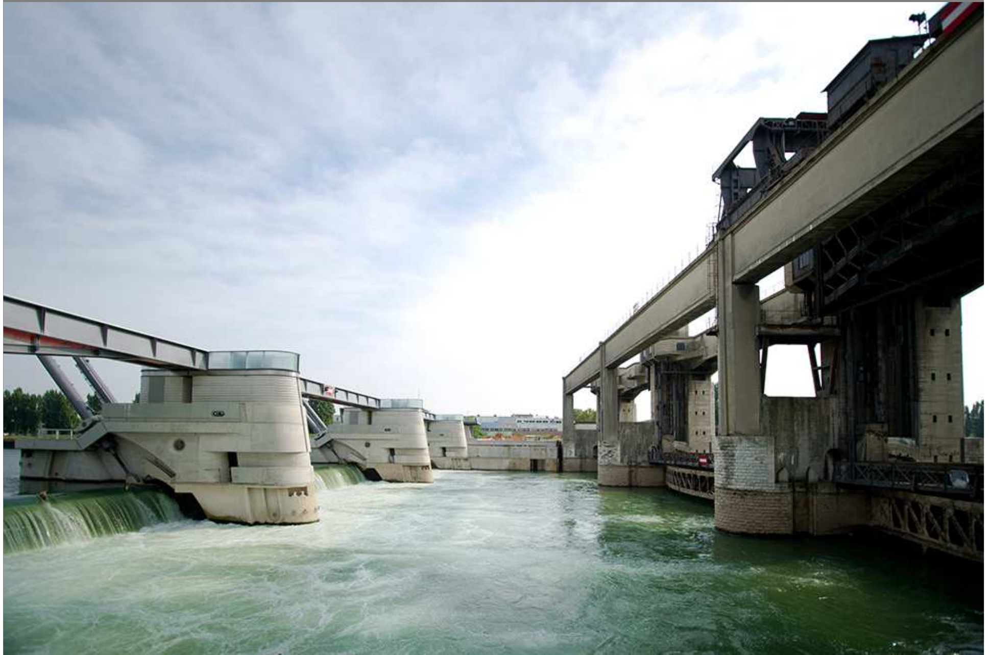
le barrage de Chatou
