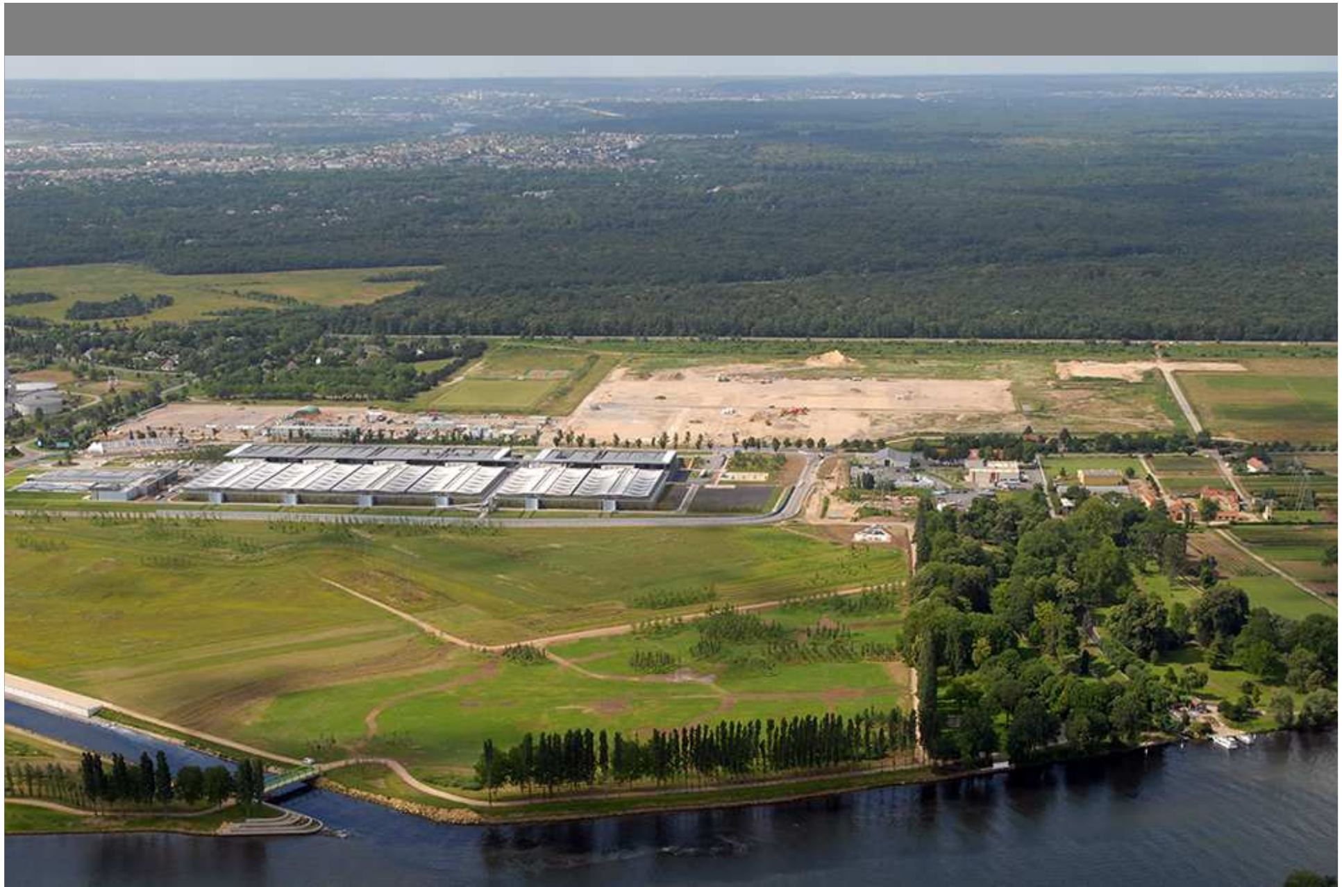
l'unité de traitement des pollutions azotées
