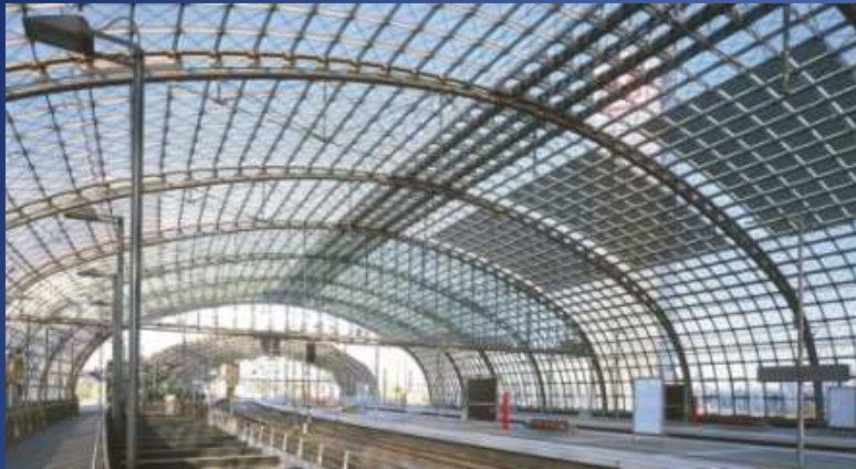
Structures en voûtes
