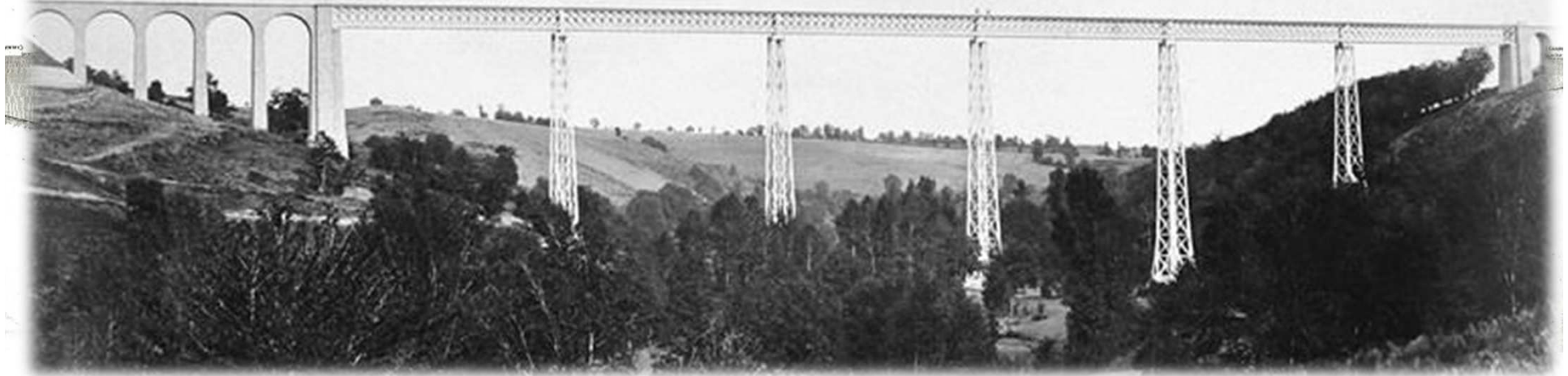
VIADUC DE LA BOUBLE.
