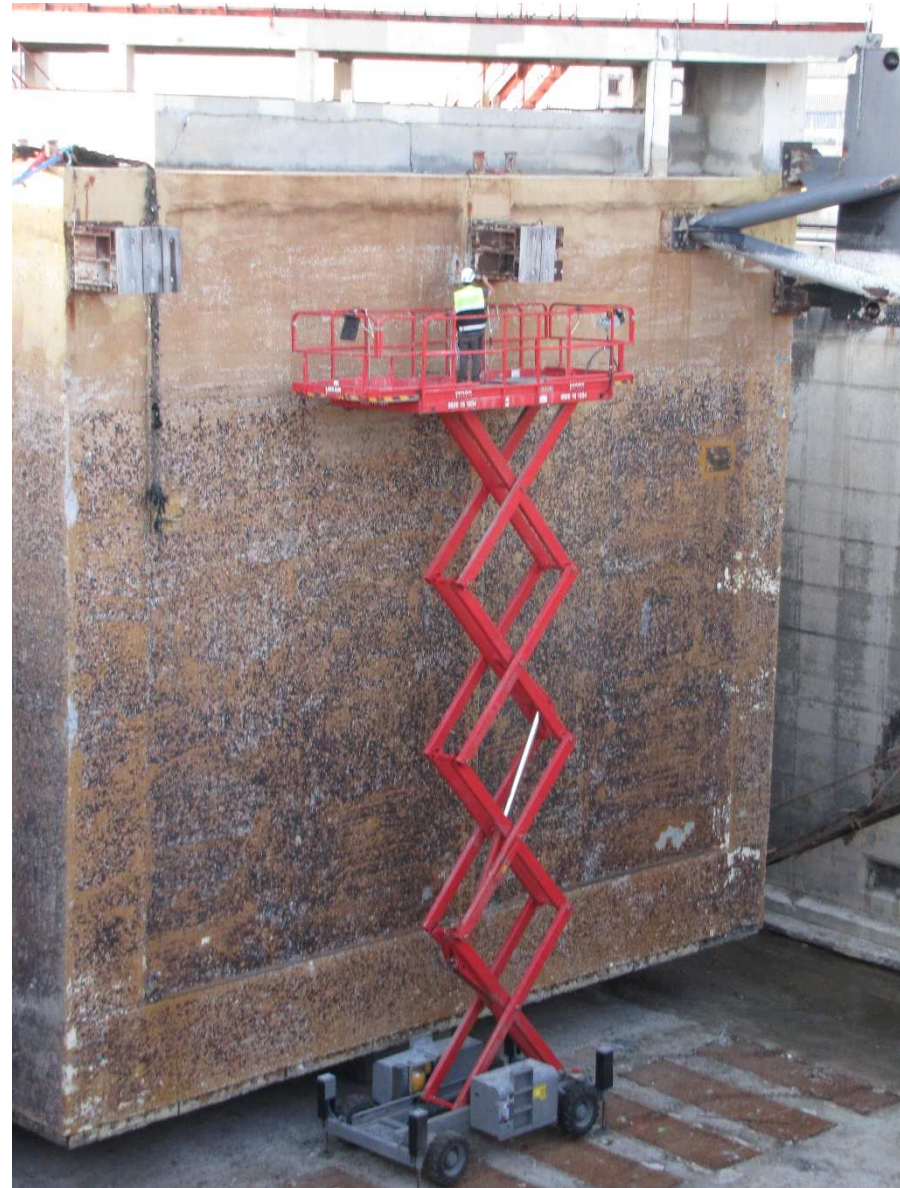
Inspection détaillée depuis la passerelle positive
