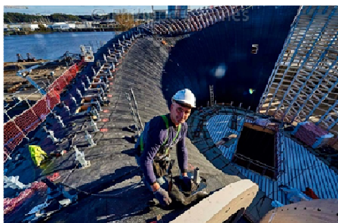
Photos du chantier extraites de la présentation Vinci
