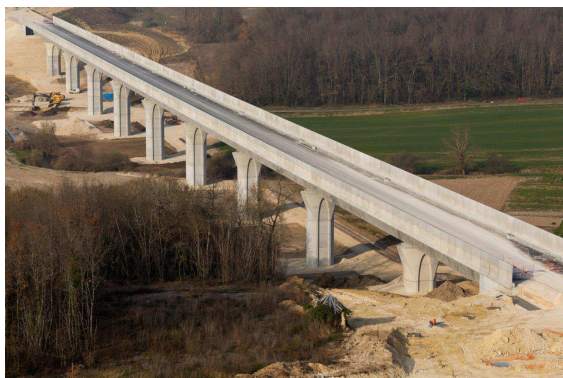
Viaduc de la Boëme (16)
