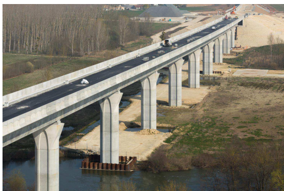
Viaduc de la Charente nord (16)
