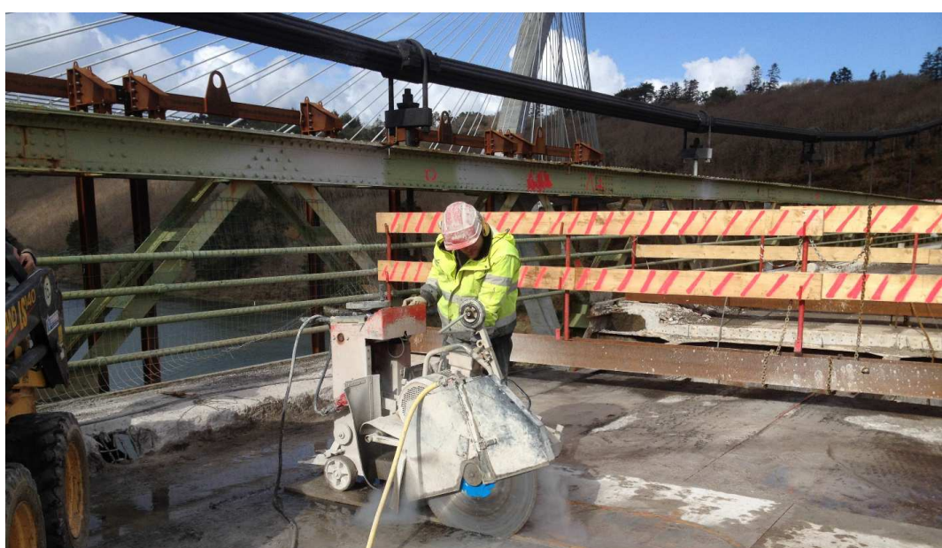
Sciage du tablier
