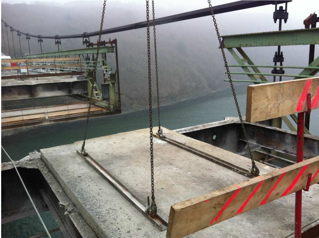
Levage des éléments du tablier béton
