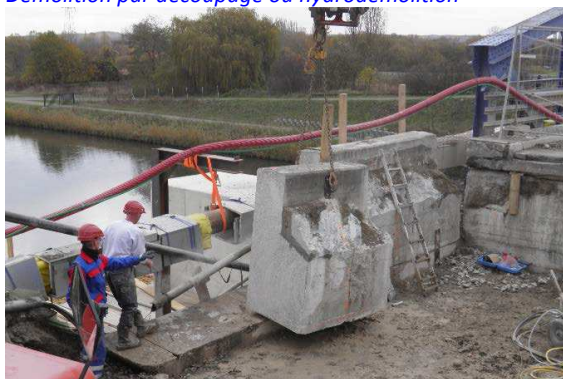
Démolition par découpage ou hydrodémolition
