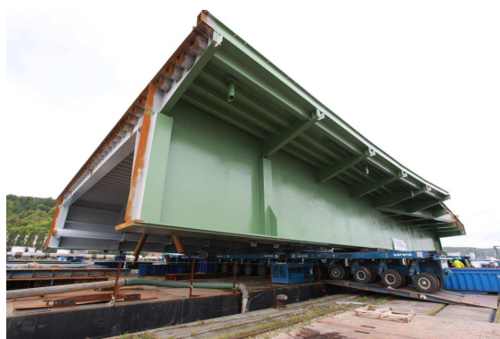
La dépose/repose de la travée métallique, la réparation M.Proost, Buyck
