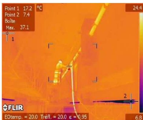
Contrôle des injections dans les gaines par camera thermique
