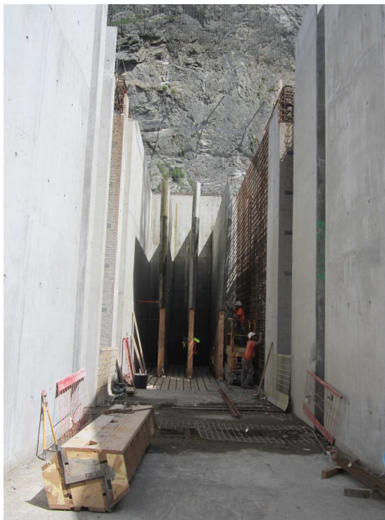
Figure 14 : Vue de la prise d'eau (41 m 3 /s) et du vortex (hauteur d'environ 10 m)
