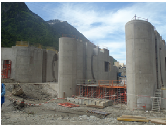
Figure 13 : Vue aval du barrage
