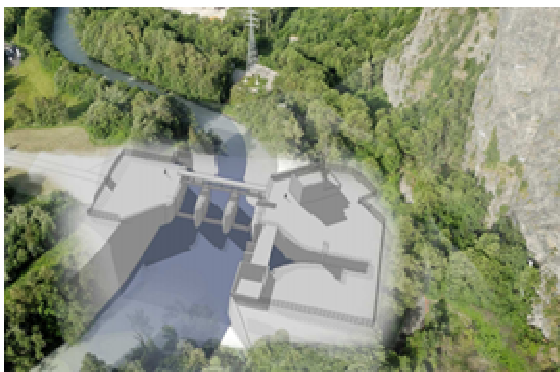
Figure 11 : Le barrage prise d'eau
