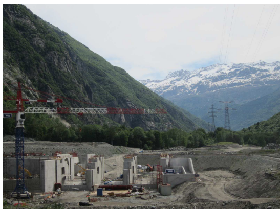
Figure 12 : Vue amont du barrage
