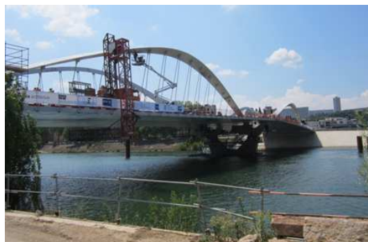
Le pont Schuman en construction
