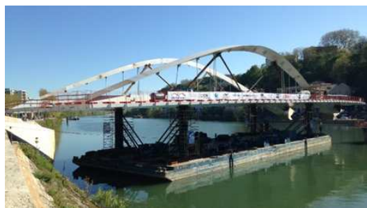
Figure 29 : Mise en place de la travée en position finale
