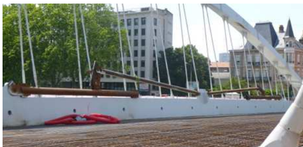
Eléments provisoires de soutènement des arches
