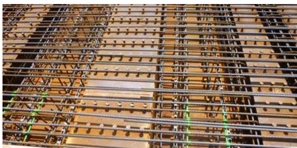
Ferrailage de la dalle en travée
