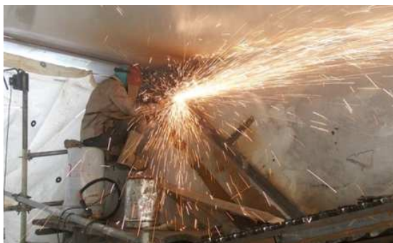
Figure 32 : Soudure finale des travées
