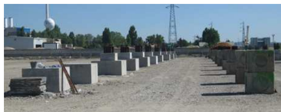
Figure 25 : Parcelle après aménagement
