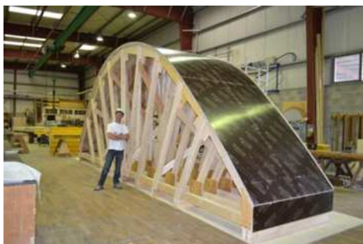
Figure 36 : Veau pour coffrage de P1
