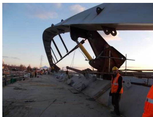
Figure 26: Système de vérins pour coucher les arches
