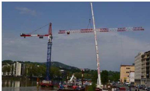
Figure 33 : Vue du chantier rive gauche
