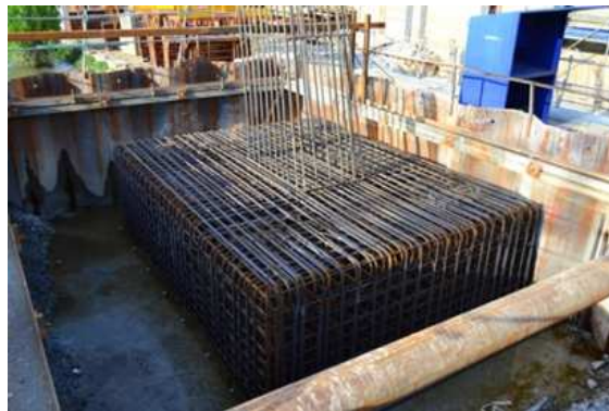
Figure 38 : Ferrailage à la base de P2
