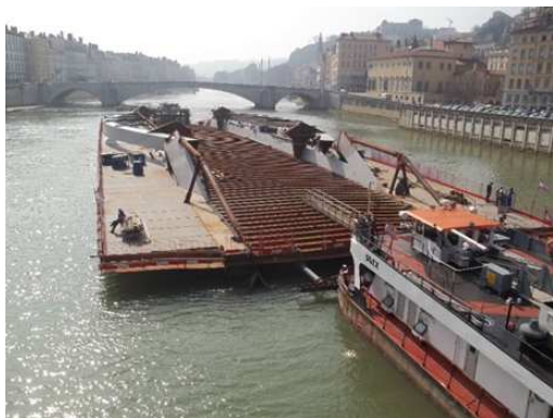
Figure 27 : Barge transportant une travée
