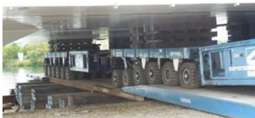
Figure 28 : Ripage de la travée sur barge
