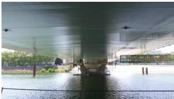
Sous-face métallique du pont
