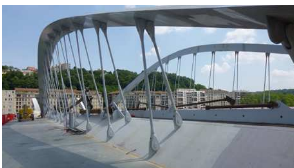
Arches avec suspentes en place
